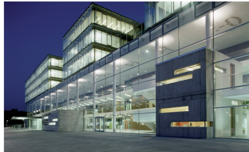
IMAGEN 5.6: Fachada principal de Complejo Judicial de Leoben FUENTE: Cháves (2013)
