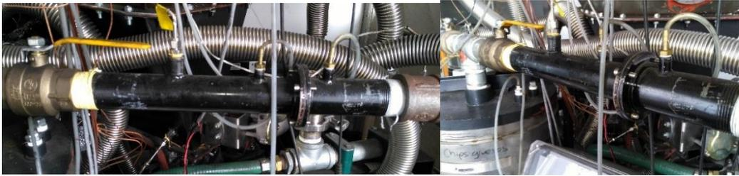
**Figura 5.5.** Medidor de flujo de orificio instalado en la planta piloto
