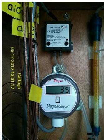
*Figura 5.8.* Instalación de transmisores de presión diferencial en la planta piloto
