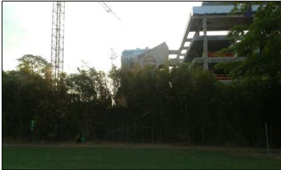
Figura 3-18. Barreras naturales en la periferia de la obra. Fuente: Autor, 2017.
