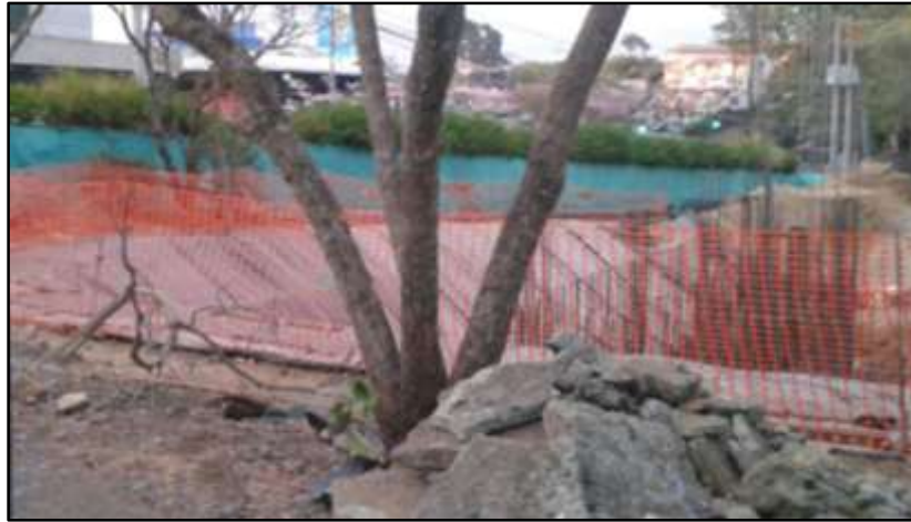
Figura 3-5. Taludes protegidos con plástico. Fuente: Autor, 2017.
