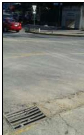
Figura 3-6. Calle frente al proyecto libre de barro o escombros. Fuente: Autor, 2017.
