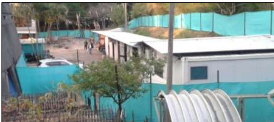
Figura 3-9. Bodegas y oficinas del proyecto. Fuente: Autor, 2017.
