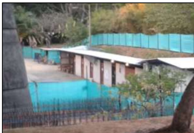
Figura 3-16. Área de servicios sanitarios. Fuente: Autor, 2017.
