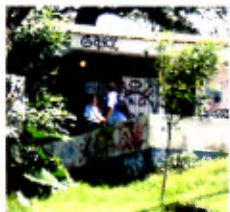
Apropiación de caseta vandalizada
