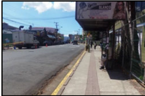
Figura 72. Construcción de aceras universales
