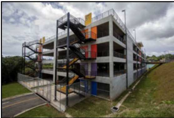
Figura 3. Nuevas edificio de parqueos
