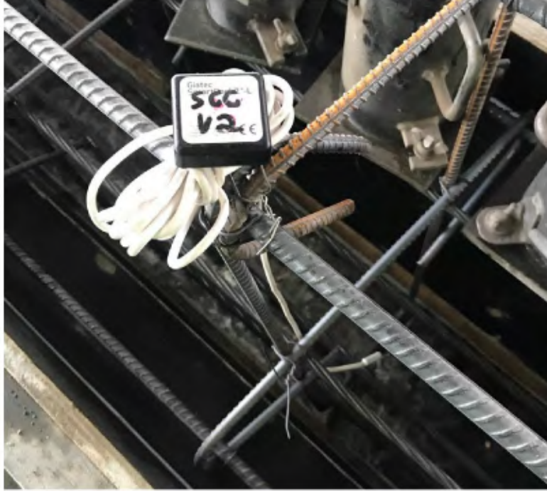
Figura 8.17. Colocación de dispositivo de madurez en viga antes de chorea.
