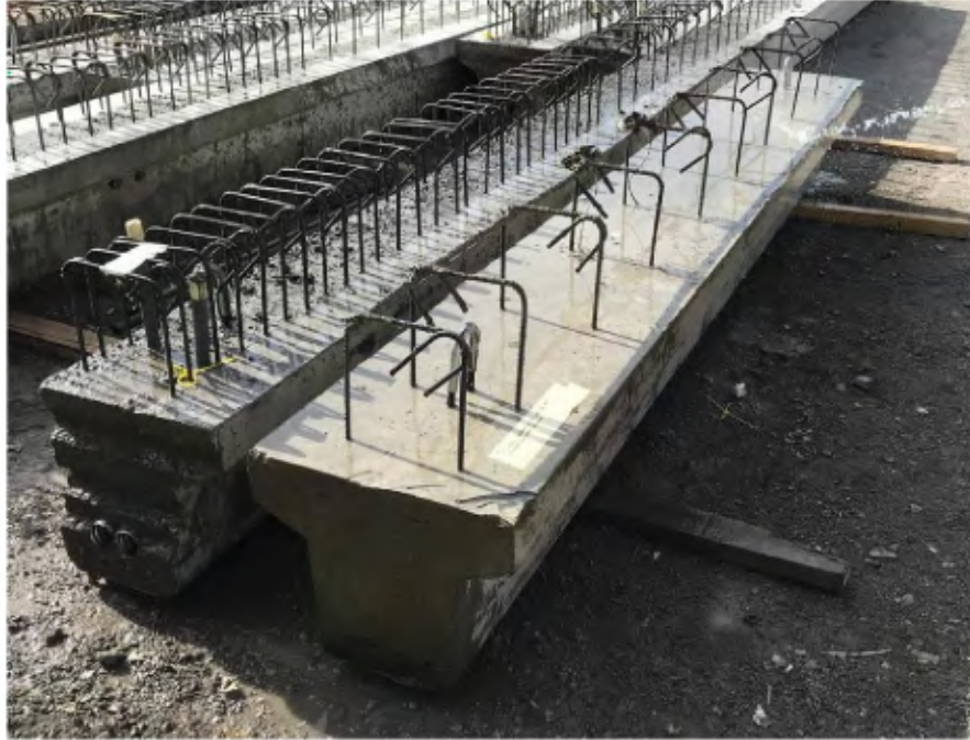
Figura 8.21. Viga curada en patio.
