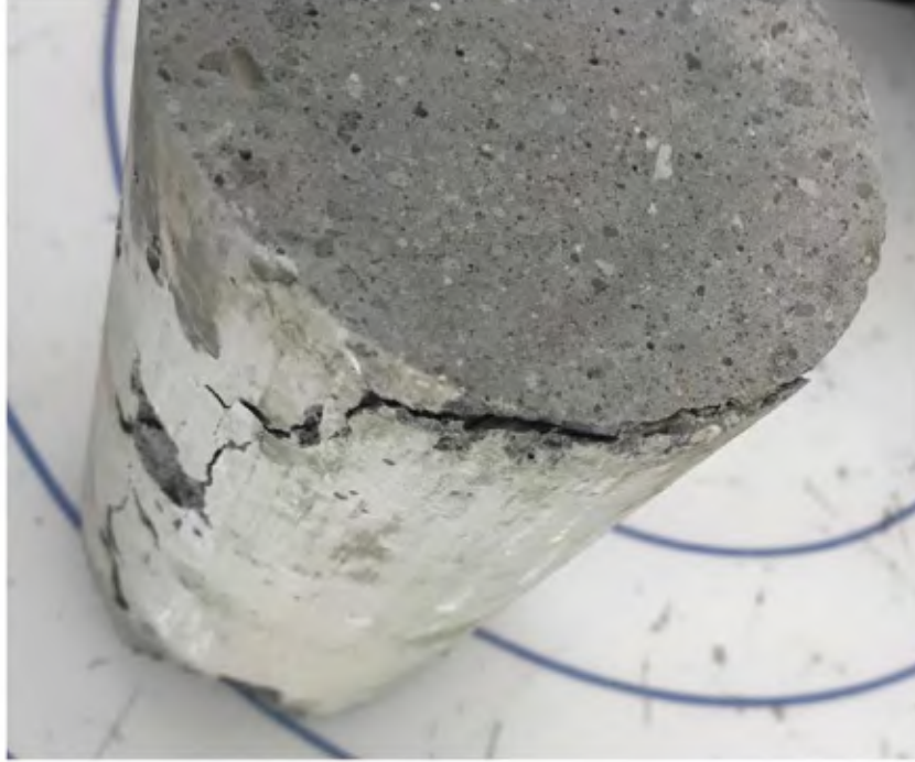
Figura 8.13 Foto de falla defectuosa a 14 días AC-CL013.
