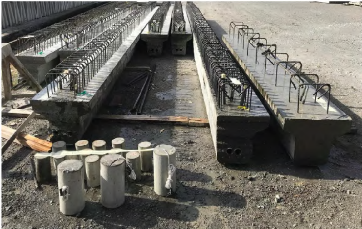
Figura 8.22. Cilindros curados junto a viga en patio.
