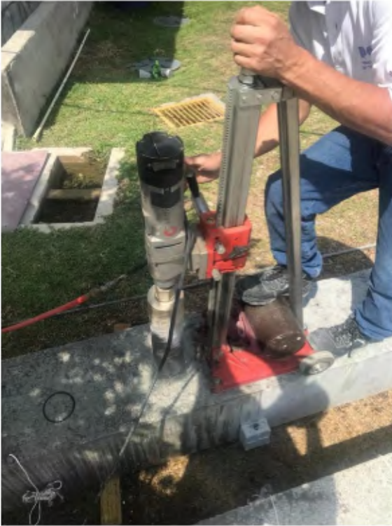
Figura 8.27. Extracción de núcleo.
