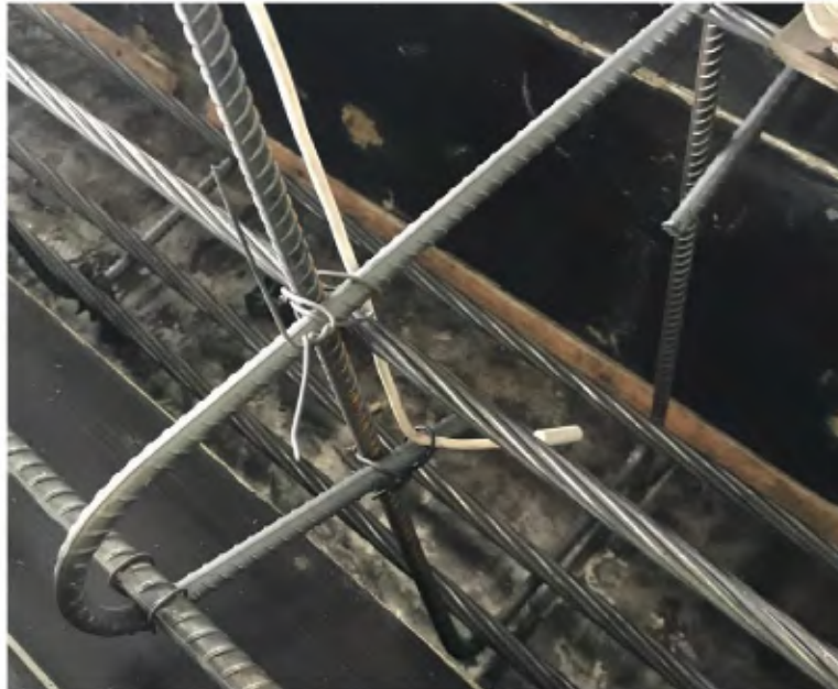
Figura 8.18. Colocación del sensor de temperatura en viga antes de chorea.
