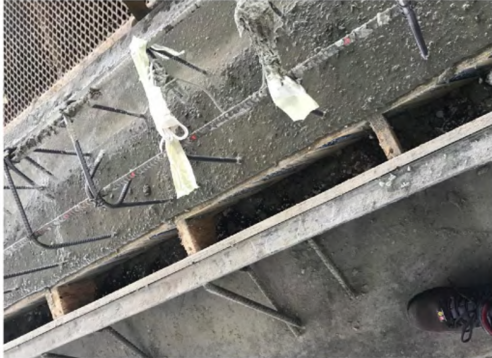
Figura 8.19. Viga choreada con sensor con concreto líquido.
