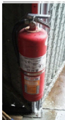
Figura 6.19. Evidencia de la observación 12, auditoría a zona B.
