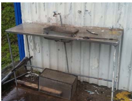
Figura 6.18. Evidencia de la observación 8, auditoría a zona B
