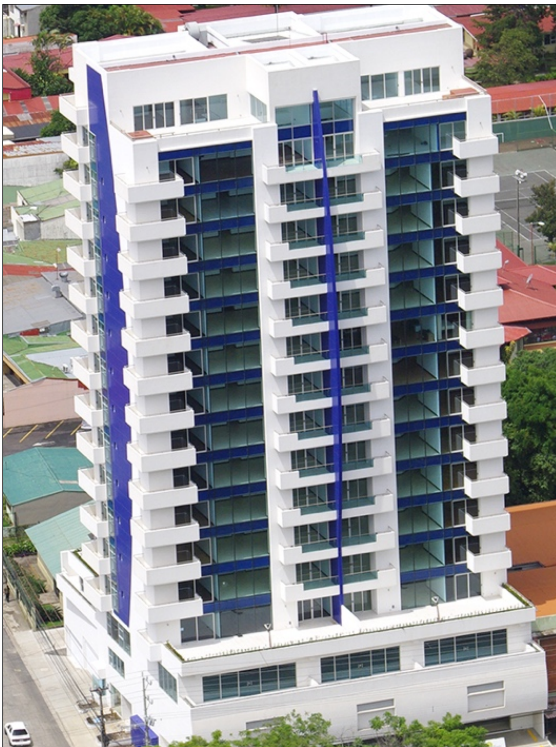
Figura 24. Vista aérea del edificio Sabana Real.
