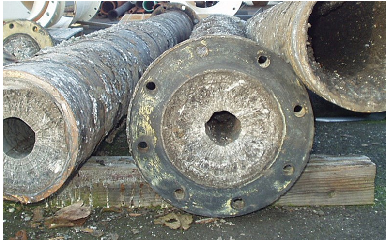
Figura 2. Incrustaciones de estruvita en tuberías
