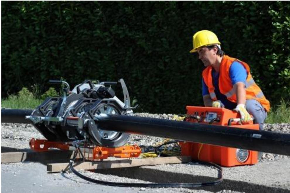
Figura 11. Equipo de electro-fusión
