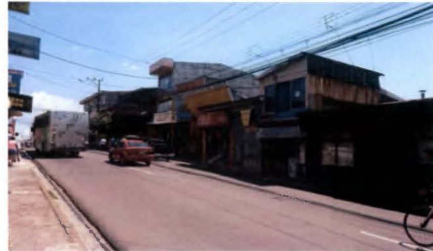
Foto 21: Edificaciones en deterioro Fuente: Elaboración Propia
