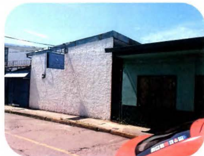
Foto 13: Fotos Área de Intervención B Fuente: Elaboración Propia
