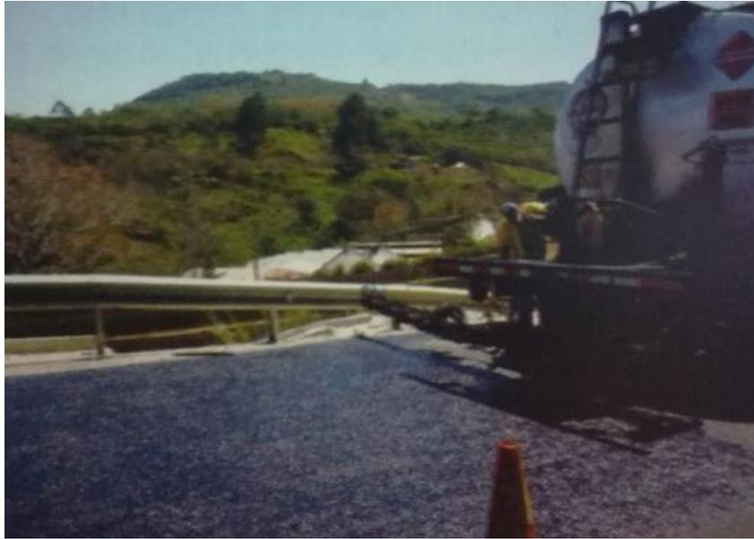
*Figura 2.9. Riego de liga uniforme sobre la superficie*
