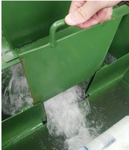
Figura 5.6: Puerta del sumidero. Fuente: Autores
