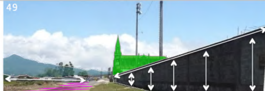
49 3 Vista del muro ciego del Estadio Municipal
