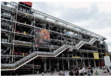
Fotografía del Centro Pompidou y su espacio público inmediato, elaboración propia
