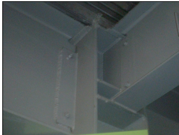
Figura 43: Conexión entre viga y columna.
