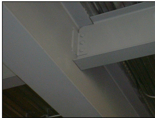
Figura 42: Conexión entre vigueta y viga.
