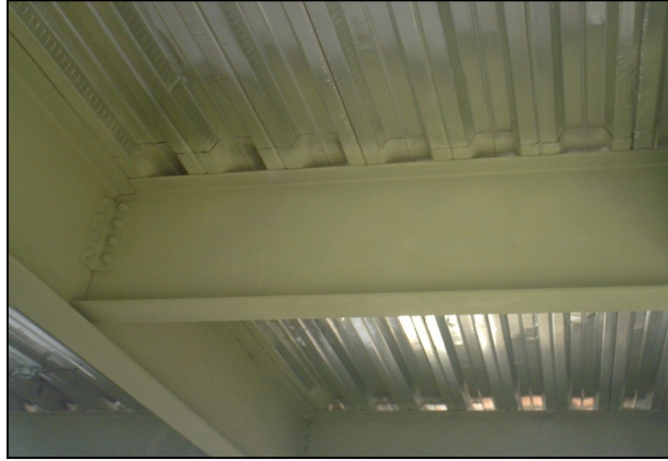
Figura 38: Conexión entre vigueta y viga.
