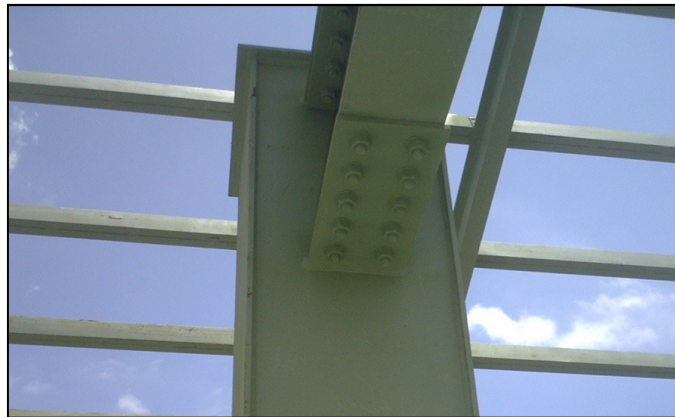
Figura 39: Conexión entre viga y columna.
