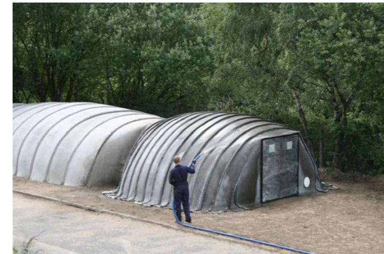
Imagen N° 57. Paso 2. Hidratando la lona Concrete Canvas. Al hidratar la lona se obtiene un espacio habitable al secarse por 24 horas. Fuente: Concrete Canvas, 2017d
