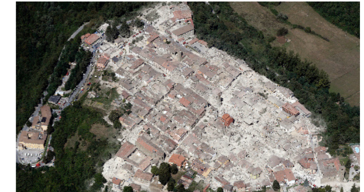
Imagen N° 30. Vista aérea de Amatrice después del terremoto del 24 de agosto del 2016. (Associated Press, 2016b)
