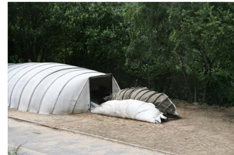
Imagen N° 56. Paso 1. Inflando la lona de Concrete Canvas. Se utiliza un inflador eléctrico para mantener la presión. Fuente: Concrete Canvas, 2017e
