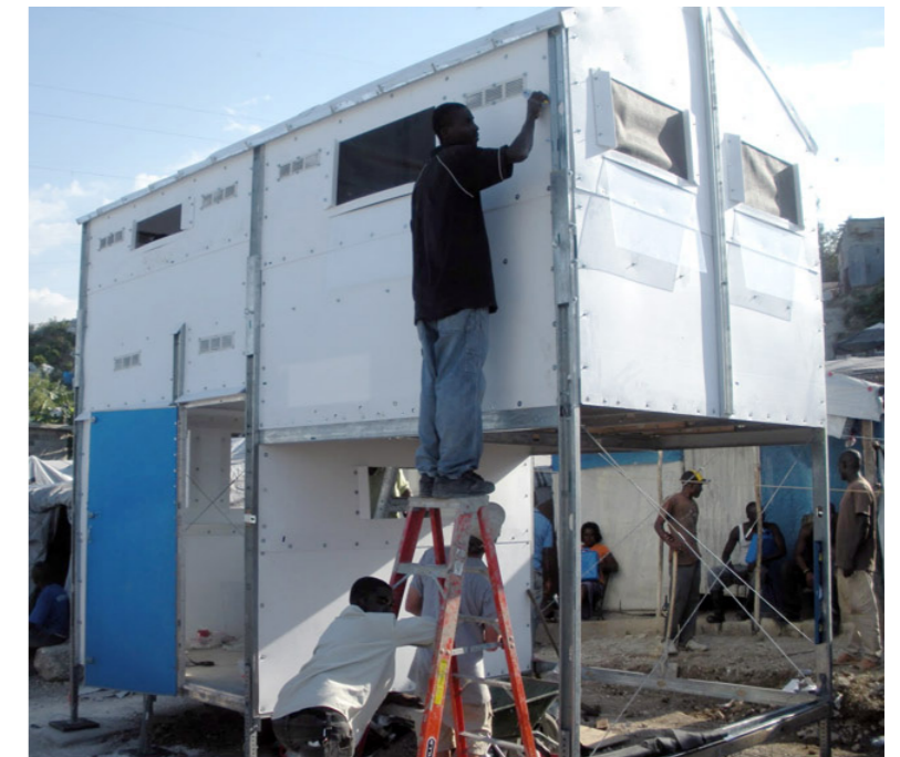
Imagen N° 72. Detalles finales de la construcción del módulo ÜBER. Fuente: Meta, 2011b
