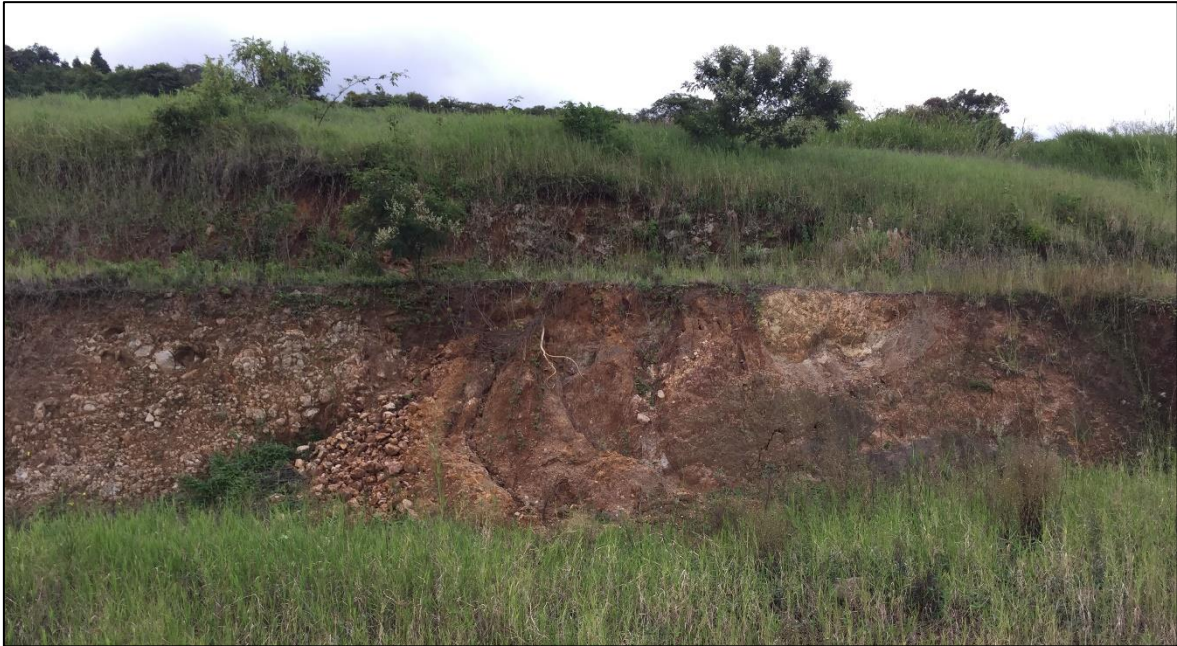
Figura 33. Talud del que se obtuvo el suelo 2
