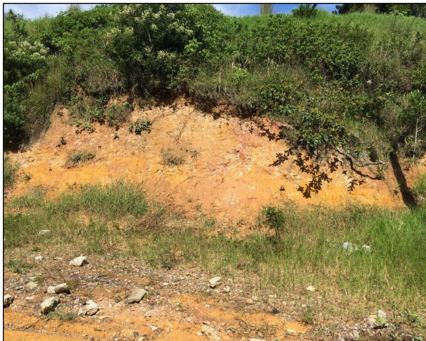
Figura 18. Talud del que se obtuvo el suelo 1
