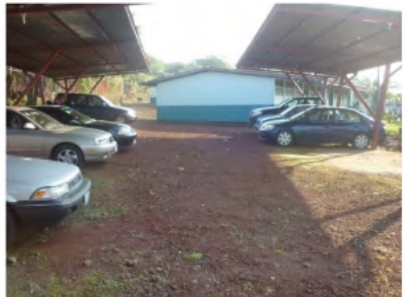
Parqueo 02 en lastre, al Norte del Gimnasio
