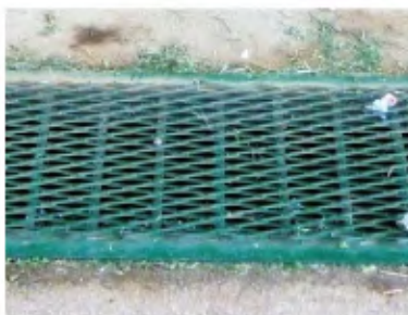
Figura 29. Modificaciones en las rejillas
