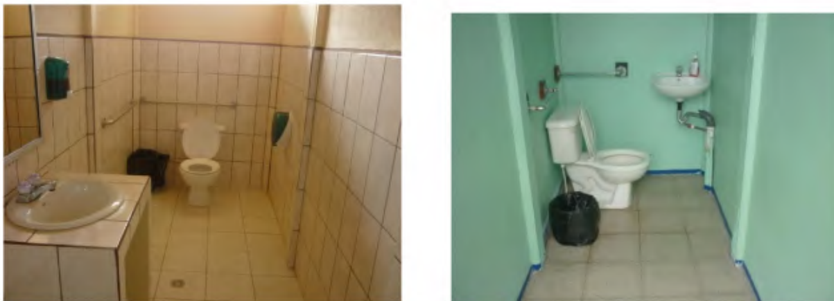
Figura 20. Sanitarios Liceo de Poás
