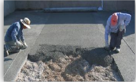
Figura 2.4. Curado con arena Fuente: www.por-box.es , s.f.
