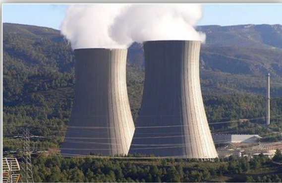
Figura 2.34. Uso del concreto pesado en una central nuclear Tomado de: civilgeeks.com, 2011
