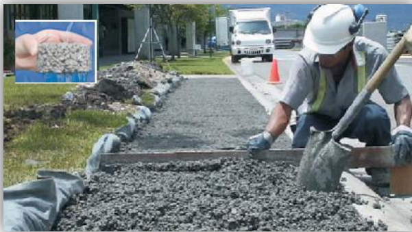
Figura 2.33. Uso del concreto permeable en una acera. Modificado de: Holcim Costa Rica, 2009
