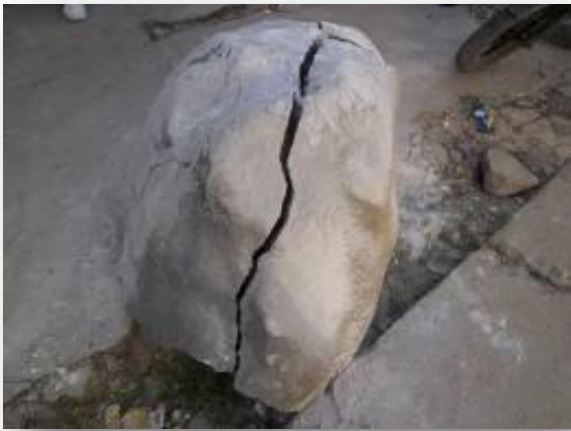
Figura 2.27. Demolición de rocas con concreto expansivo Tomado de: http://medellin.olx.com.co/no-mas-explosivos-demolicion-rocas-y-concretos-y-mineria-con-cemento-expansivo-iiid-258957640
