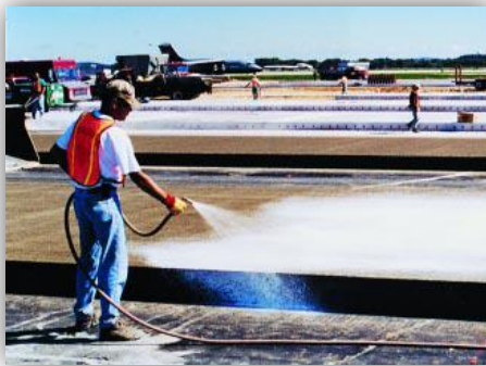
Figura 2.7. Curado con compuesto líquido formador de película Fuente: Kosmatka, 2004
