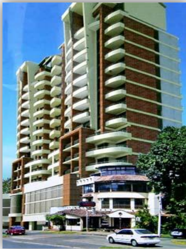
Figura 2.16. Edificio cuya base y primeros niveles cuentan con CAR Tomado de: Zamora, 2009
