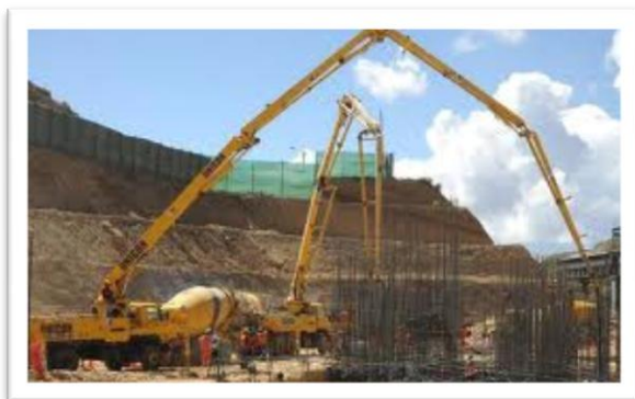
Figura 2.20. Equipo usado para el concreto bombeado Tomado de: http://civilgeeks.com , 2011
