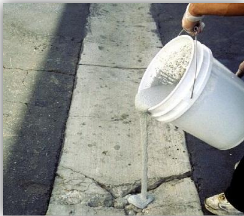
Figura 2.22. Reparación de una estructura con concreto con polímeros
