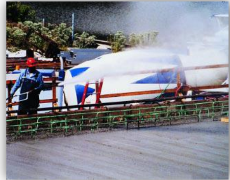
Figura 2.2 Rociado con neblina Fuente: Kosmatka y otros, 2004
