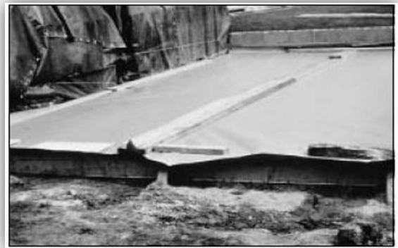
Figura 2.6. Curado con papel kraft Fuente: civilgeeks.com, 2011
