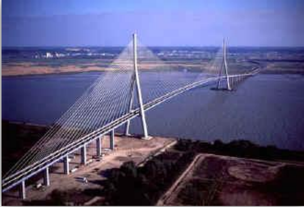
Figura 2.13. Puente de Normandía, Francia, construido con CAD de micro sílice, llegando a alcanzar 60 MPa Tomado de: imcyc.com, 2011
