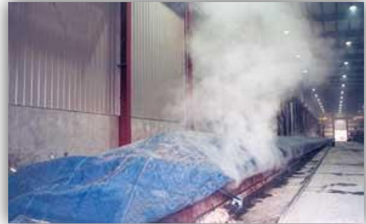
Figura 2.8. Curado con vapor de vigas estructurales Fuente: besser.com/kraft_energy/espanol/aplicaciones-hormigon-pretensado.htm
