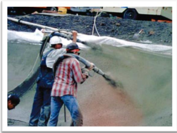
Figura 2.30. Concreto lanzado Tomado de: Kosmatka y otros, 2004
