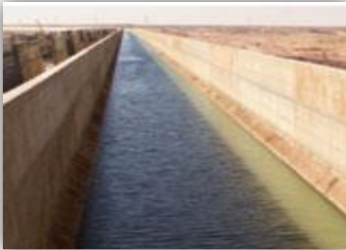
Figura 2.19. Uso de concreto de baja permeabilidad en un canal
