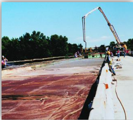
Figura. 2.3. Curado con alfombra Fuente: Kosmatka y otros, 2004
