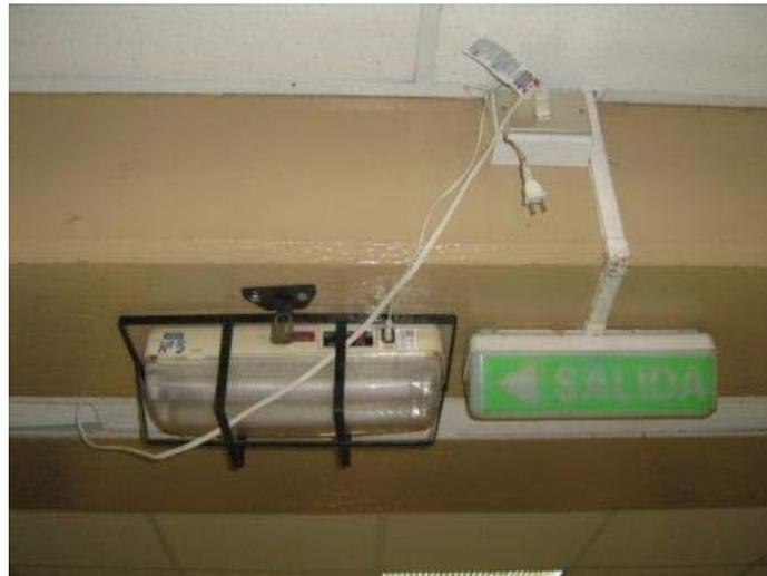
Figura #23. Desconexión de lámpara de emergencia para conectar extensión en su lugar.
