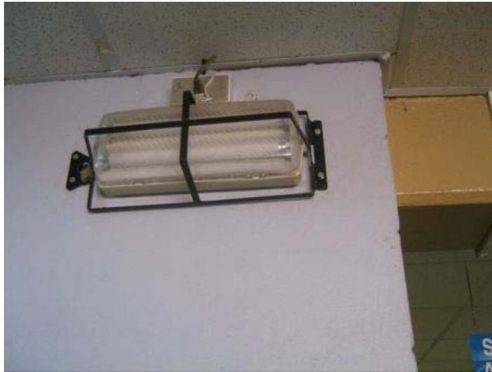
Figura #22. Lámpara de emergencia desconectada para utilizar el tomacorriente que le corresponde.
