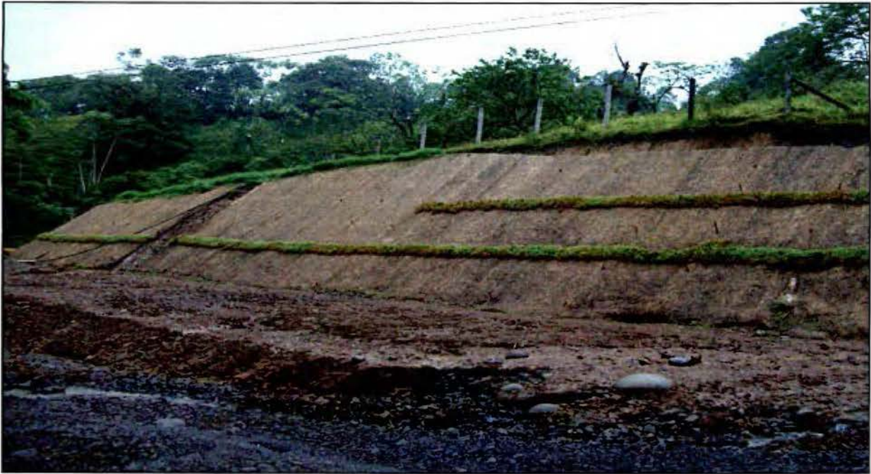
Figura 5.6. Uso combinado de biomantas y cespedones para control de erosión. Fuente: Silva, 2012
