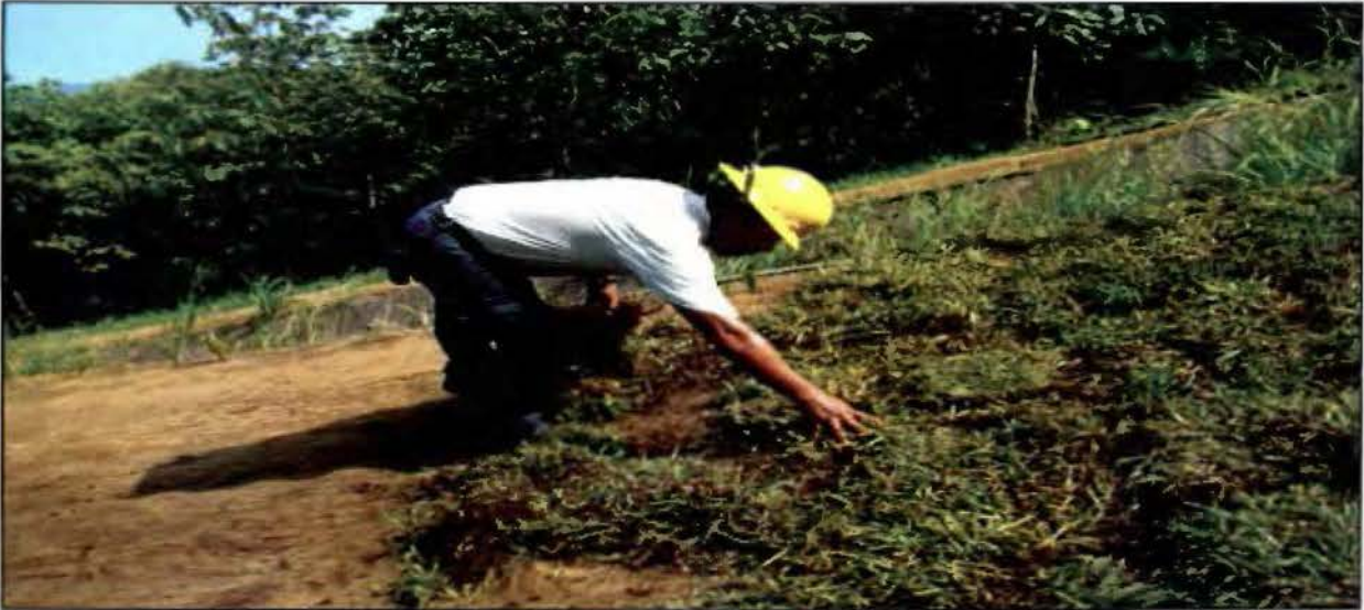
Figura 5.14 Revegetación de taludes con zacate jengibrillo Fuente: ICE, 2011
