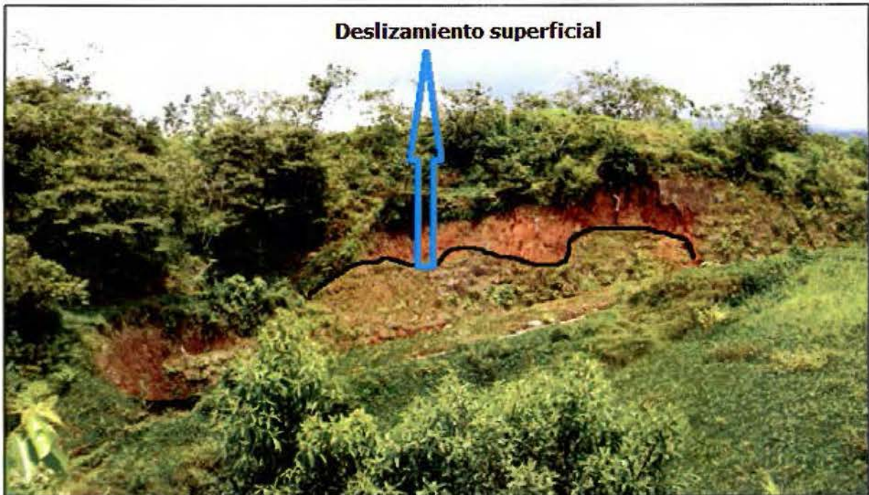
Figura 5.5. Deslizamiento en el talud producto de la lluvia que genera disminución en la resistencia del suelo. Fuente: Silva, 2012
