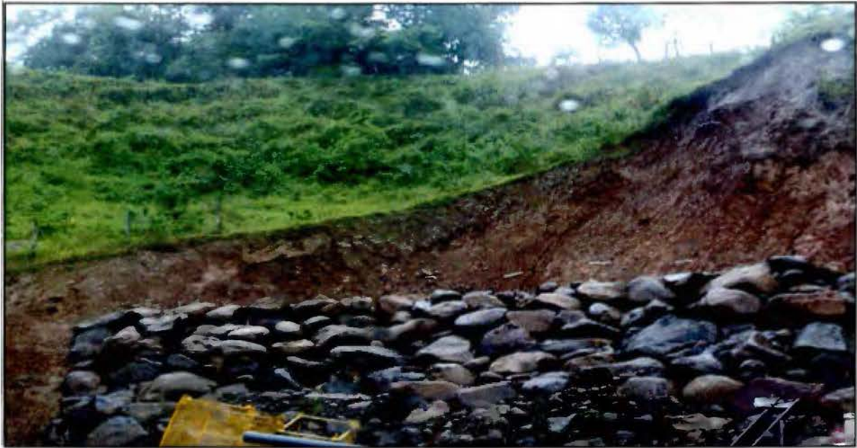
Figura 5.7 Estabilización mediante enrocado Fuente: Silva, 2012
