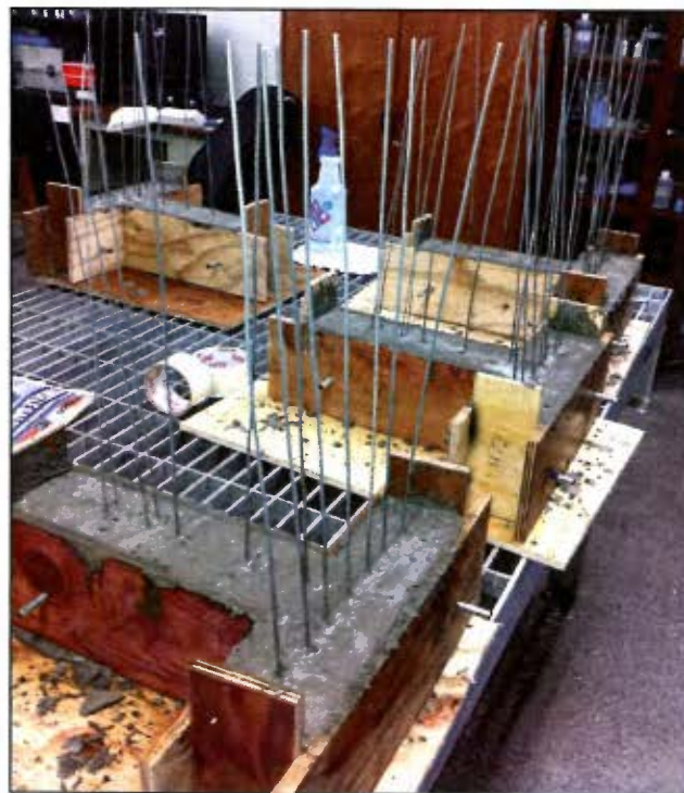
Figura 23. Vigas de fundación.
