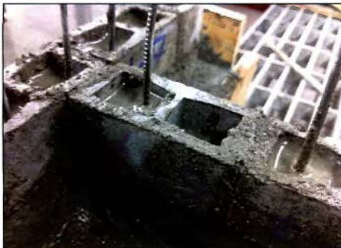
Figura 28. Colocación del microconcreto de relleno.
