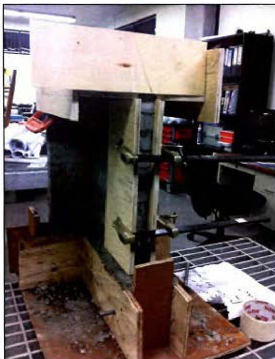
Figura 33. Encofrado de muros integrales.
