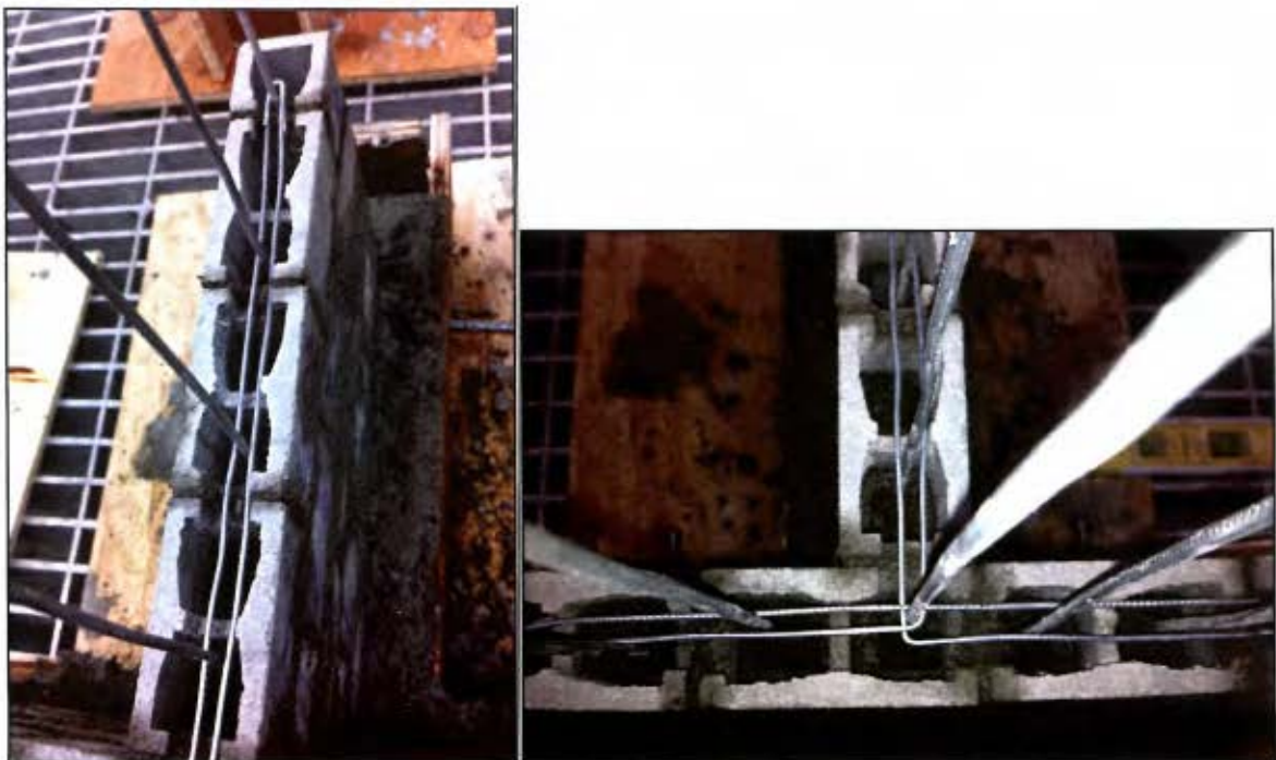
Figura 26. Acero de refuerzo horizontal.
