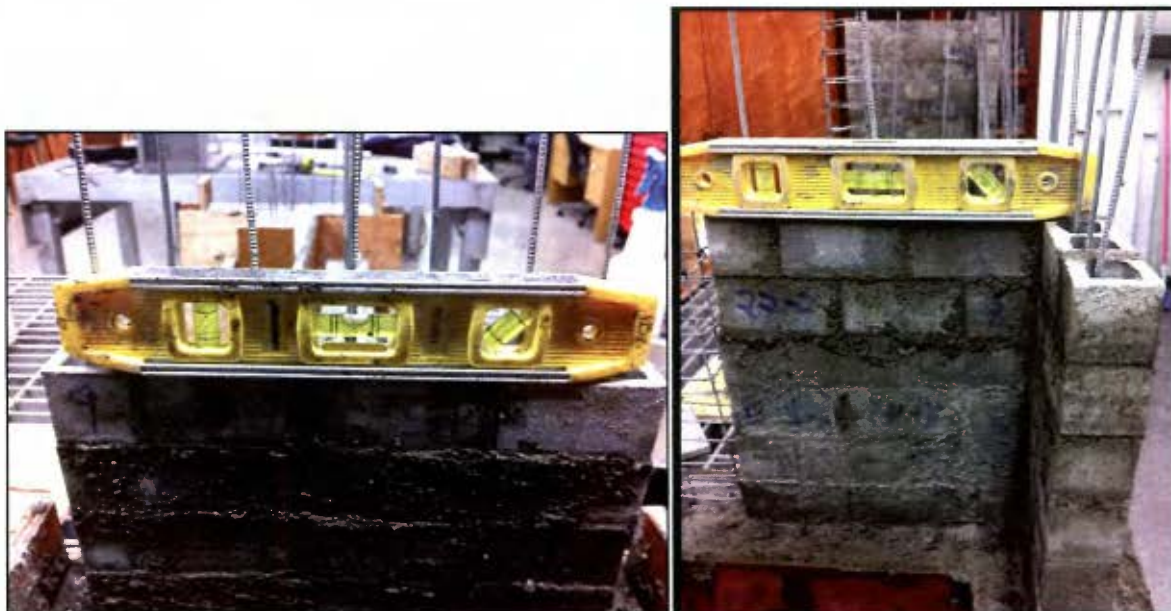
Figura 29. Alineamiento horizontal de los muros.
