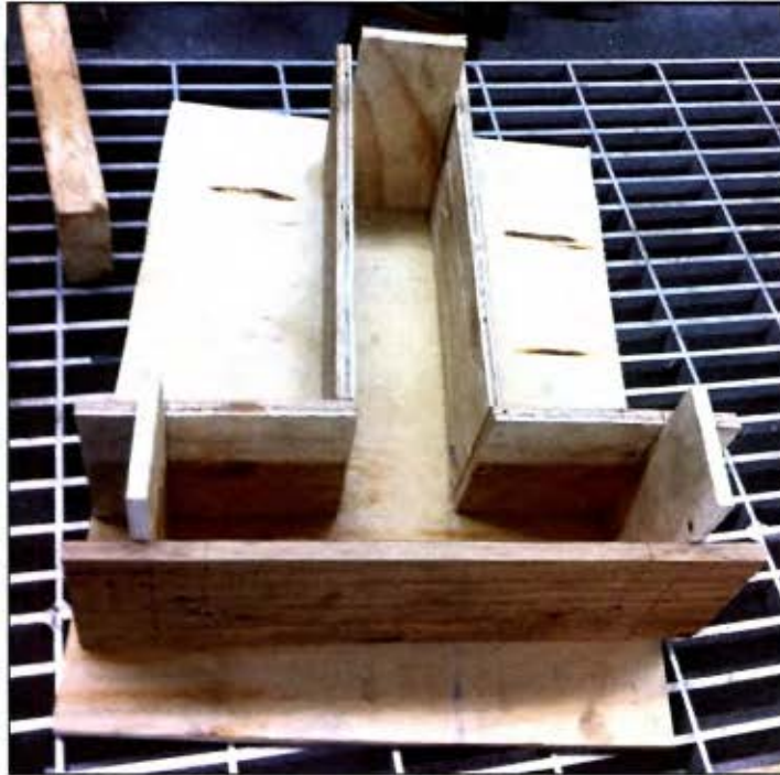
Figura 20. Encofrado de viga de fundación.
