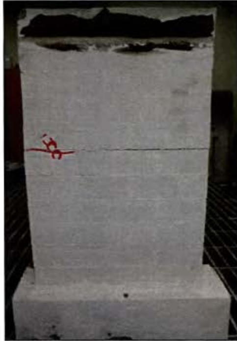
Figura 53. Muro 4 después de la falla (vista posterior).
