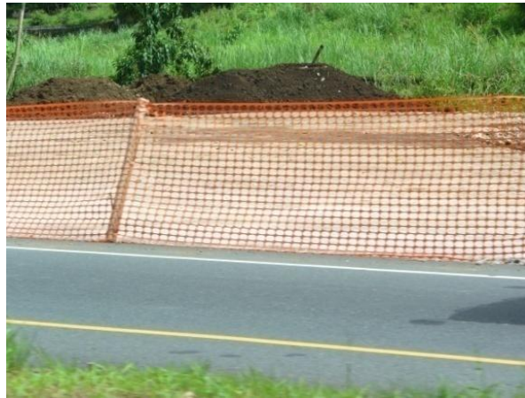
Fotografía 7.51 Zona en construcción en el tramo 2.
