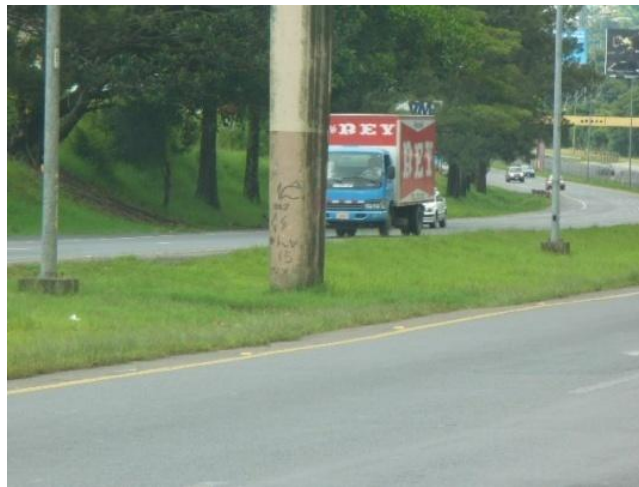
Fotografía 7.26 Columna de concreto de puente sin protección además de postes de acero para iluminación.
