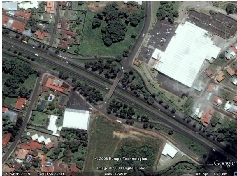
Figura 5.4 Vista aérea del intercambio Lomas de Ayarco (final tramo 2).
