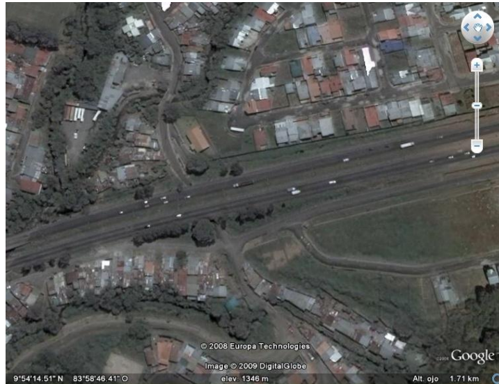
Figura 5.7 Vista aérea de la entrada a Tres Ríos (final tramo 5).
