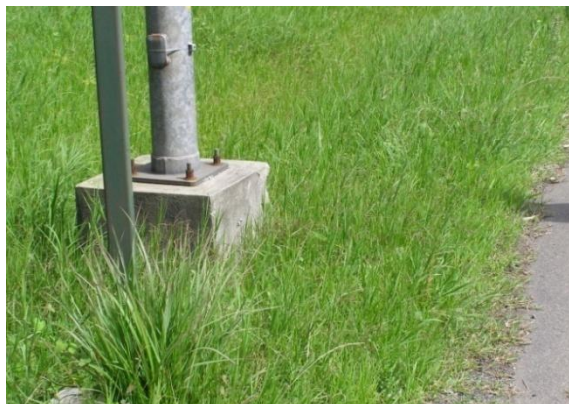
Fotografía 7.20 Poste de alumbrado con base rígida presente en la mediana.
