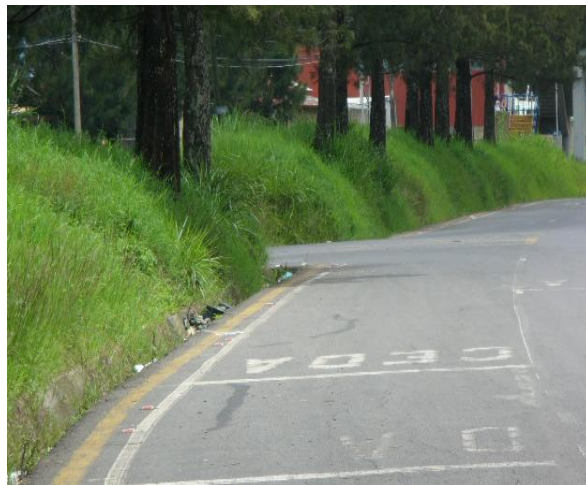
Fotografía 7.62 Radios de giro cortos y problemas de visibilidad.
