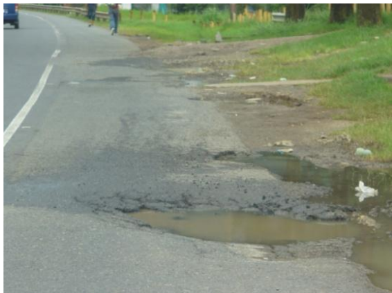
Fotografía 7.17 Deterioro del espaldón en tramos 5 y 7.
