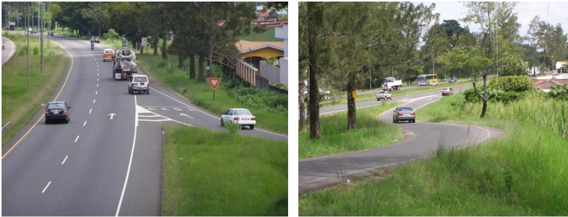
Fotografía 7.56 Ausencia de carril de aceleración y vallas de contención en las rampas.
