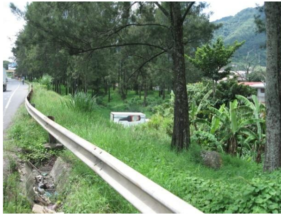
Fotografía 7.10 Buen estado para las condiciones relacionadas con los objetos fijos.
