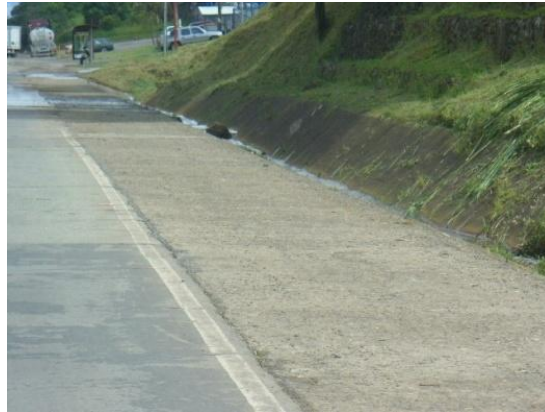
Fotografía 7.7 Cuneta en buen estado.
