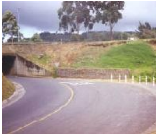
Fotografía 7.66 Túnel de acceso con barras de acero.
