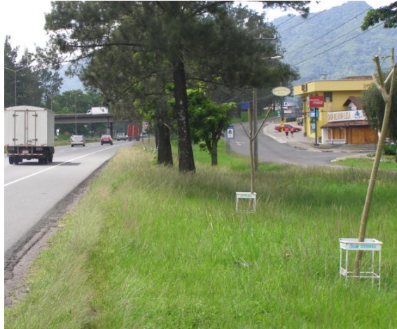
Fotografía 7.57 Presencia de árboles al margen de la vía.
