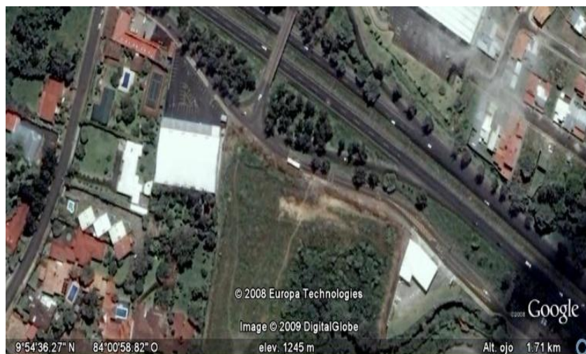
Figura 5.5 Vista aérea de zona de las Villas (final del tramo 3).
