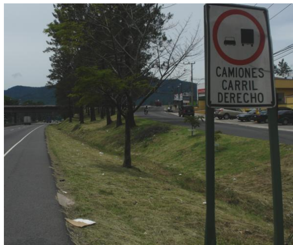
Fotografía 7.61 Talud de corte no traspasable.
