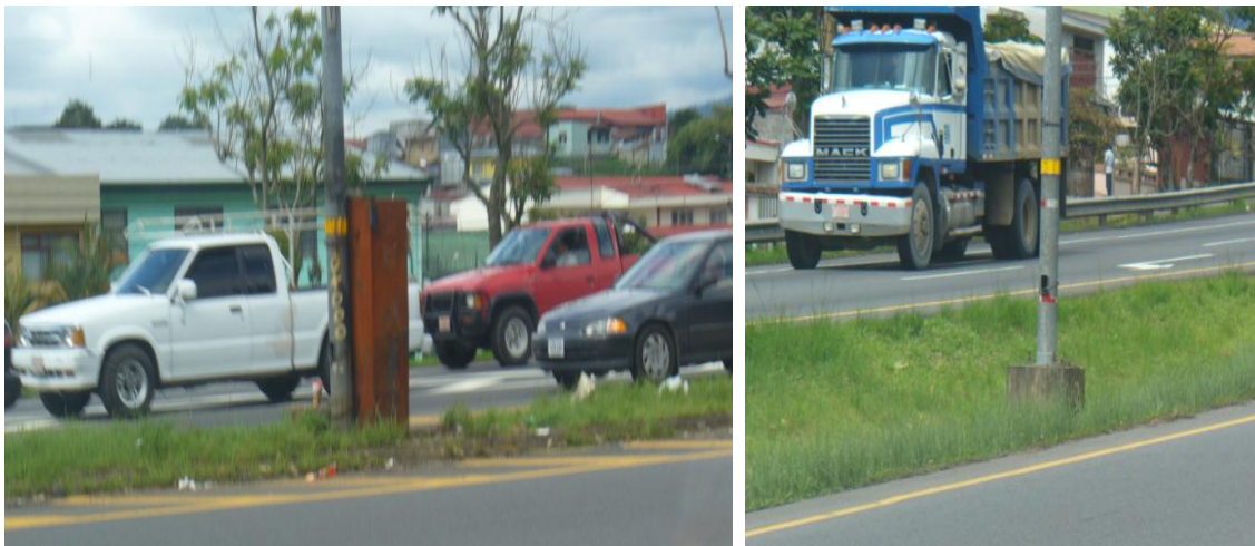
Fotografía 7.54 Objetos fijos en la mediana sin protección.
