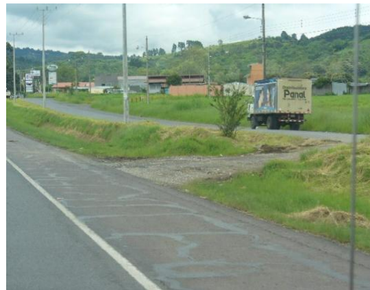
Fotografía 7.17 Deterioro del espaldón en tramos 5 y 7.
