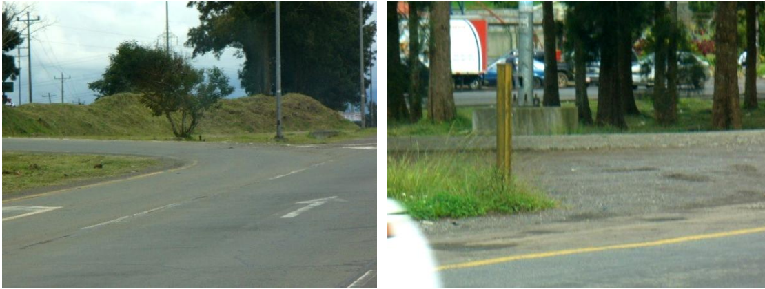
Fotografía 7.71 Radios de giros cortos sin protección y con objetos de alta rigidez cerca de la vía.
