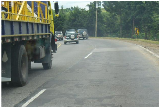
Fotografía 7.13 Calzada que presentaba deterioro severo con reparación. Actualmente presenta sello de grietas.
