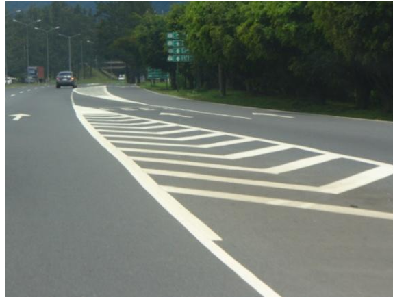
Fotografía 7.19 Demarcación adecuada y en buen estado en el tramo 2.
