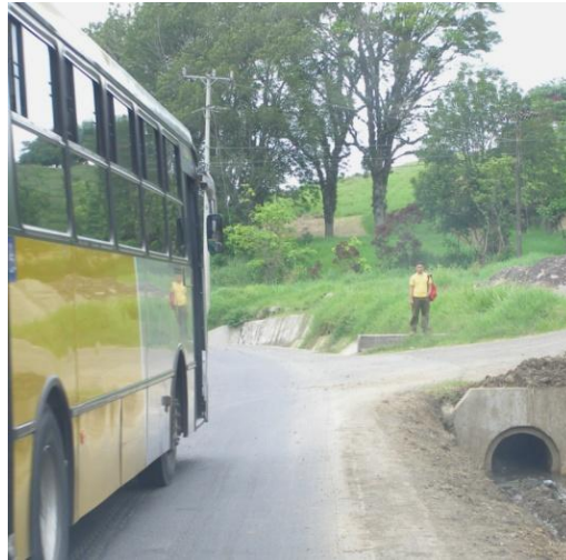
Fotografía 7.34 Paradas de autobús a la orilla de la vía, sin la presencia de bahías ni protección para los usuarios.
