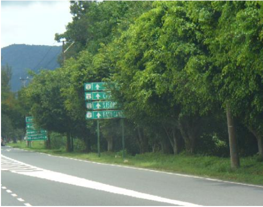
Fotografía 7.16 Tramos 2 y 5 en los que el espaldón desaparece de manera abrupta.
