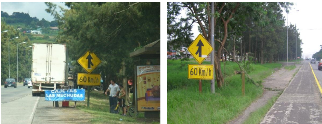
Fotografía 7.22 Señales ubicadas a muy baja altura incumplimiento con SIECA y además con problemas de visibilidad por la vegetación (tramo 8).
