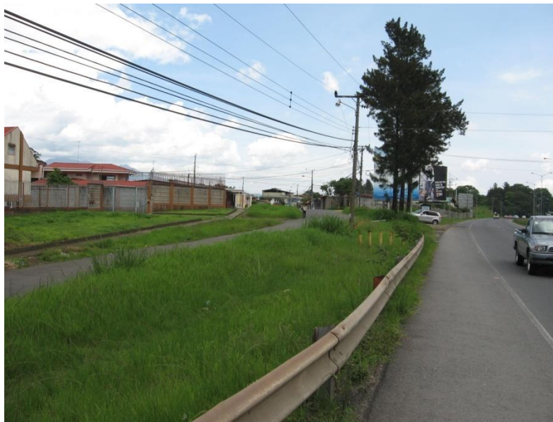
Fotografía 7.1 Estado aceptable en barreras semi-rígidas.
