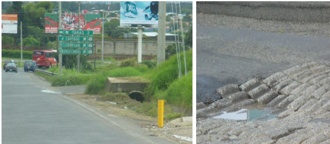
Fotografía 5.7 Perspectiva de la autopista en el sector de Taras.
