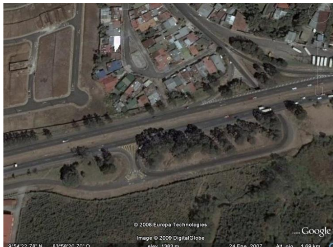
Figura 5.8 Vista aérea de la intersección con radios inferiores a 200m, ubicado 2 km después de la entrada a Tres Ríos (final tramo 6).
