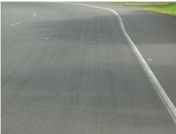
Fotografía 7.15 Superficie con tratamiento para reducir lisura.
