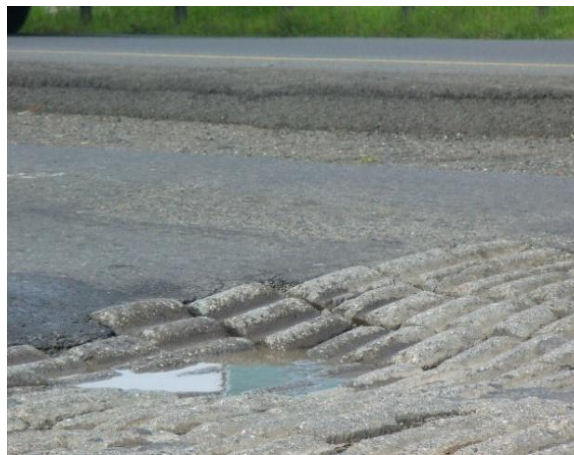
Fotografía 7.73 Reductores de velocidad conocido como trepidadores.
