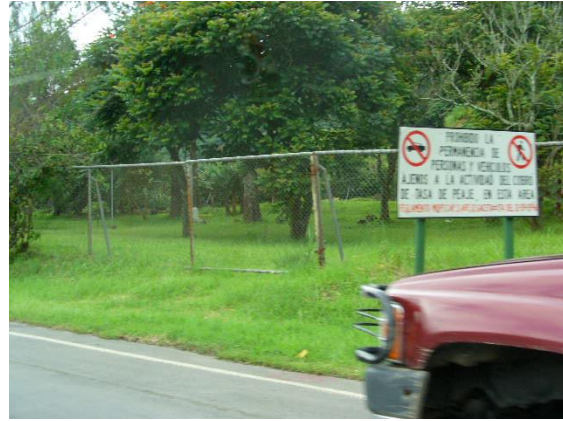
Fotografía 7.16 Tramos 2 y 5 en los que el espaldón desaparece de manera abrupta.
