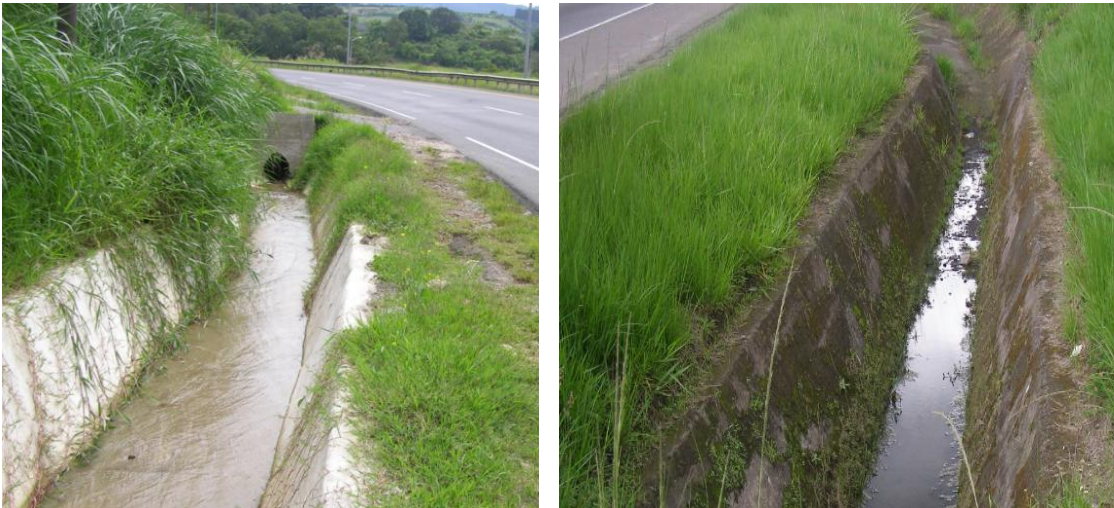
Fotografía 7.49 Cunetas sin protección.
