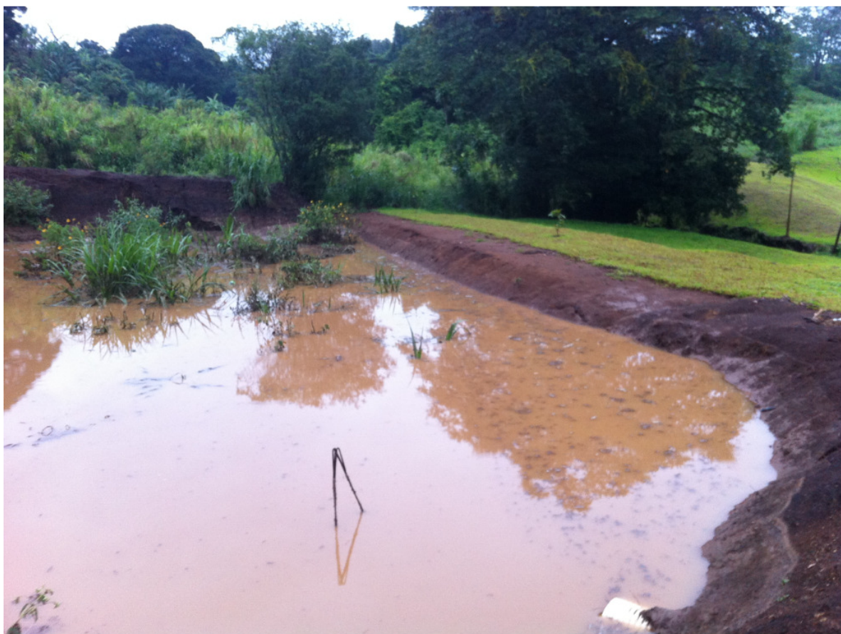
Figura 50. Laguna de retención en funcionamiento
