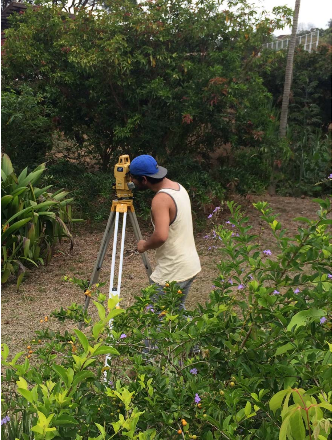
Figura 39. Levantamiento de las secciones transversales en la Quebrada Valverde
