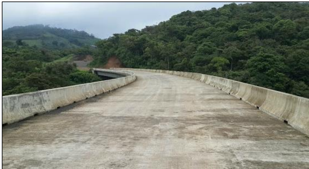
Figura A-2. Vista a lo largo de la línea de centro- Puente sobre el Río Barranca
