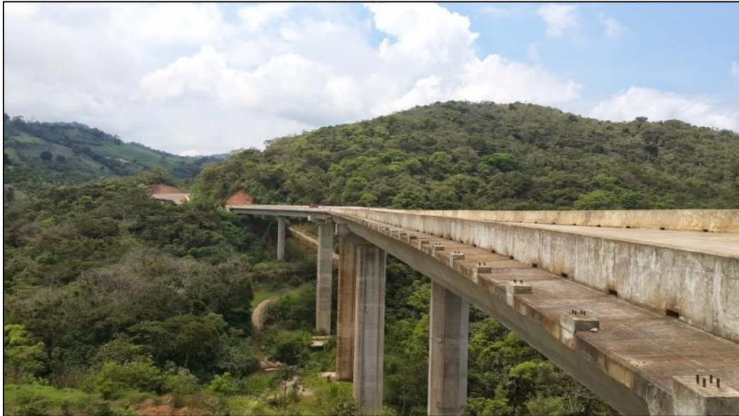
Figura A-1. Vista lateral- Puente sobre el Río Barranca
