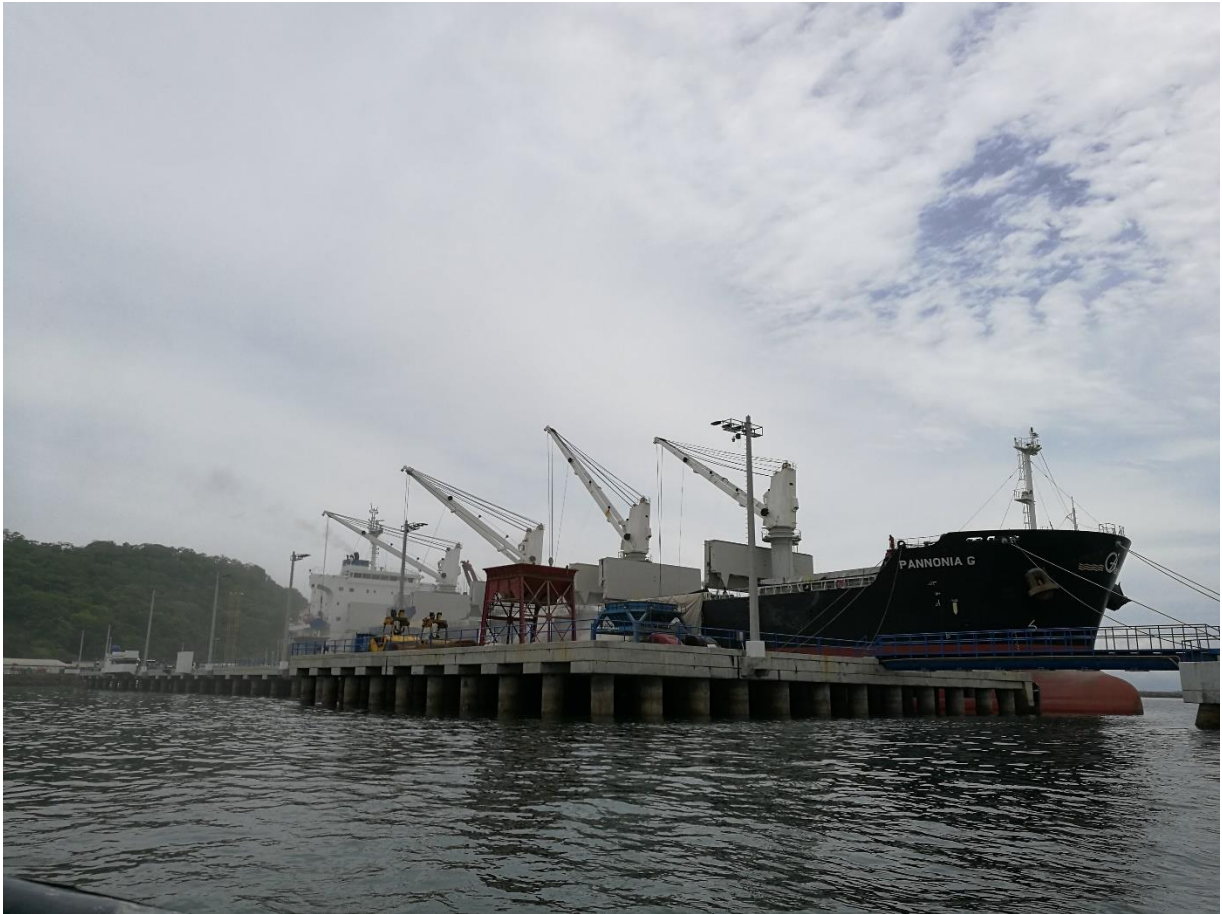
Figura 1.1. Puerto de Caldera en Costa Rica.
