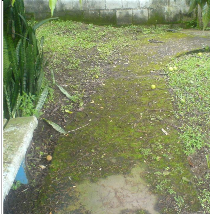
Figura 4.18 Contrapiso de las aceras exteriores. Fuente: El Autor
