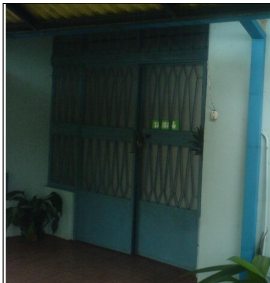
Figura 4.19 Acceso al edificio. Fuente: El Autor
