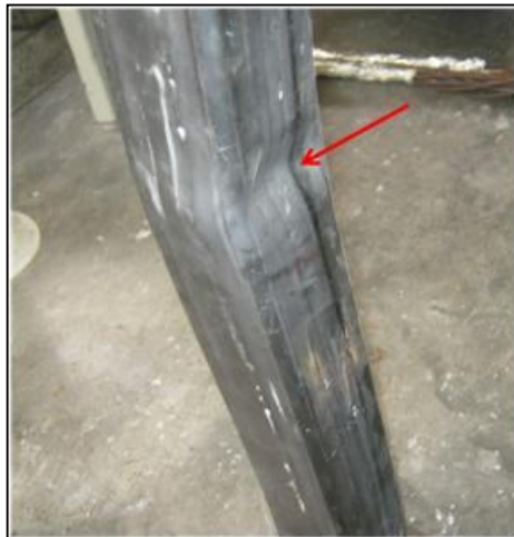
Figura 6.7. Falla típica de pared en los especímenes.
