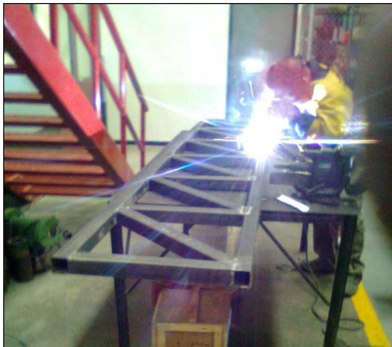
Figura 5.13. Proceso constructivo de las armaduras.
