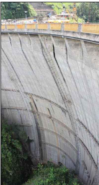
Figura 27. Fotografía de la presa de Cachi
