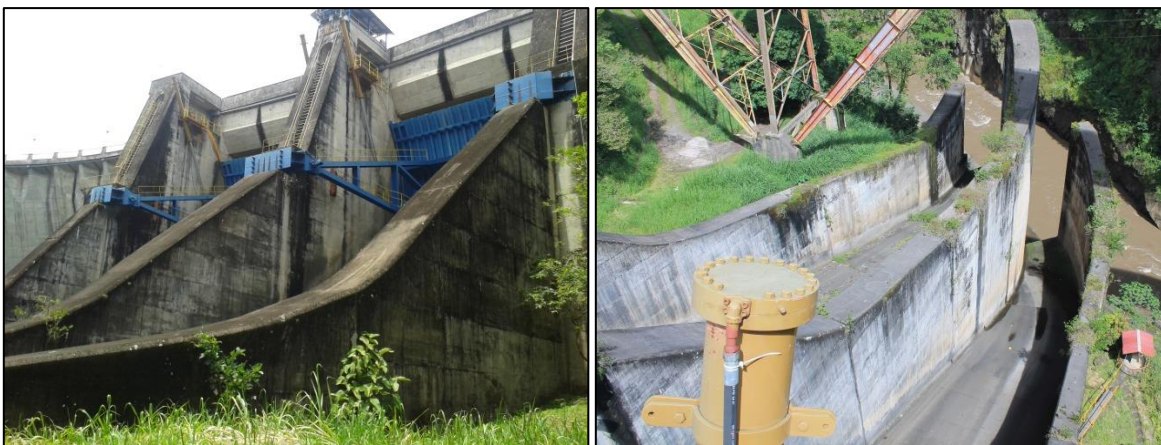
Figura 33. Fotografías del vertedero de excedencias de la P.H. Cachí
