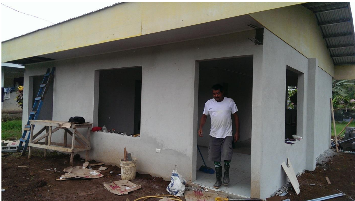
Figura F-8. Vivienda para adulto mayor ubicada en Palmera de San Carlos y construida en el 2016
