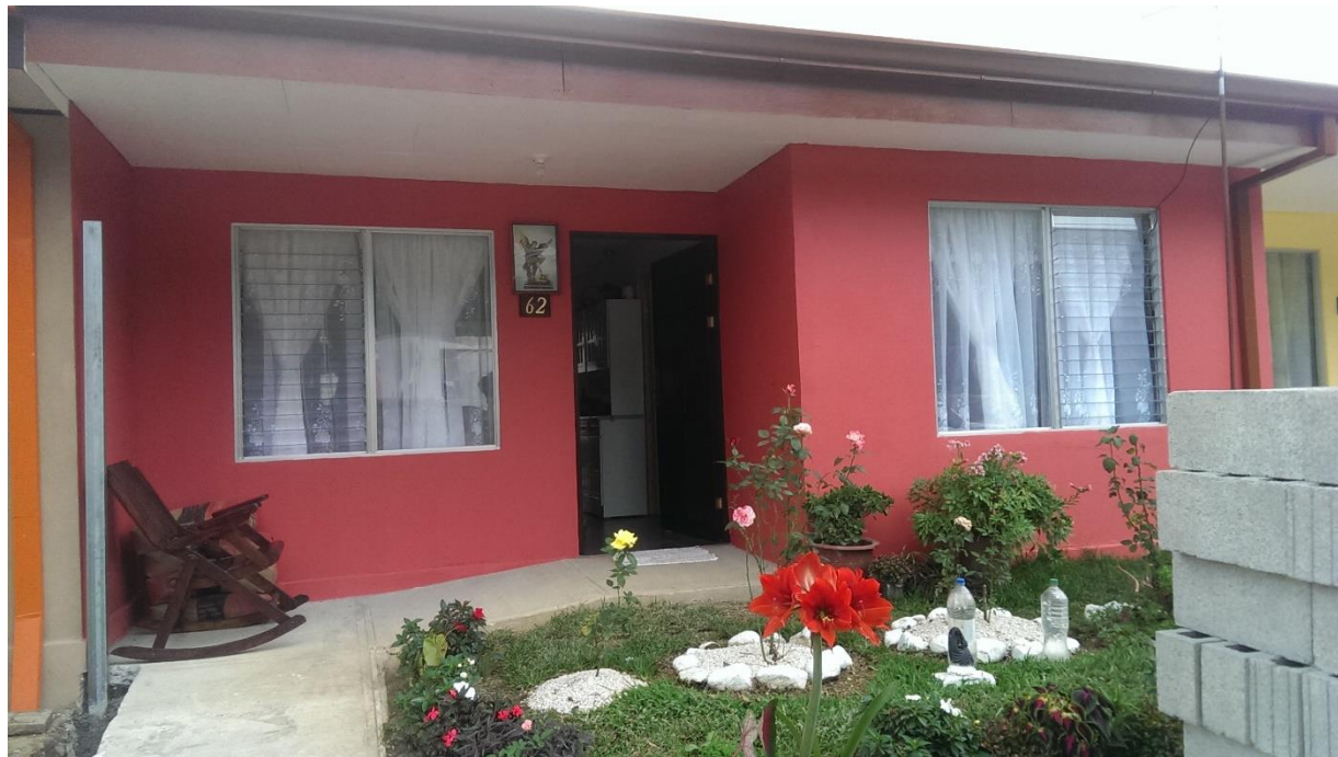
Figura F-15. Vivienda para adulto mayor ubicada en Orosi de Paraíso y construida en el 2015
