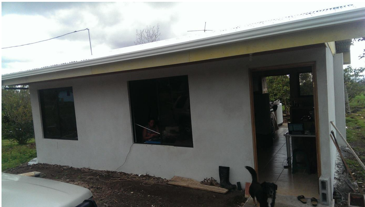
Figura F-12. Vivienda para adulto mayor ubicada en Aguas Zarcas de San Carlos y construida en el 2016
