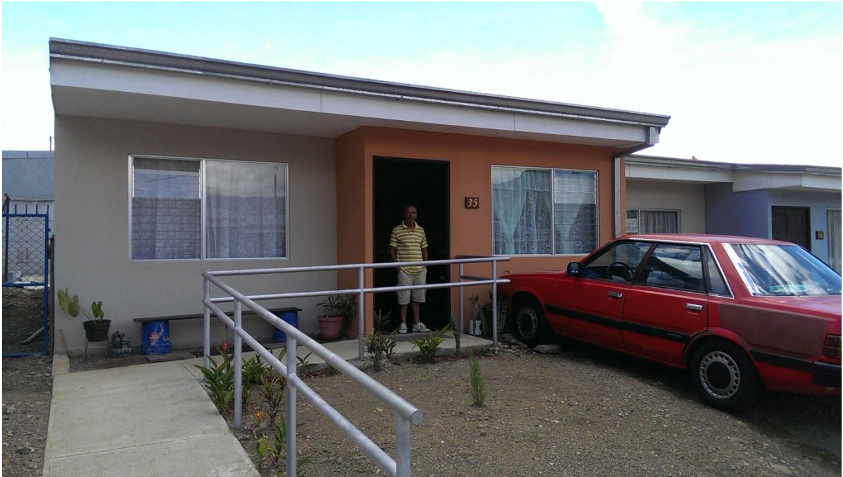
Figura F-13. Vivienda para adulto mayor ubicada en Orosi de Paraíso y construida en el 2015
