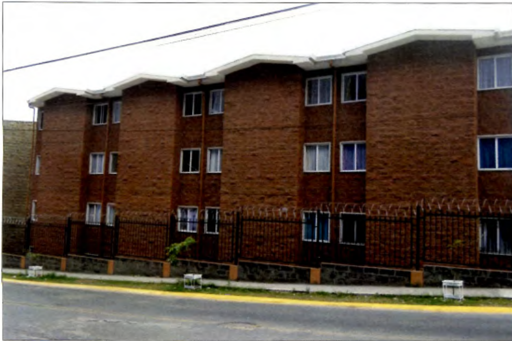
Figura 3-4. Fotografía de edificio de apartamentos
