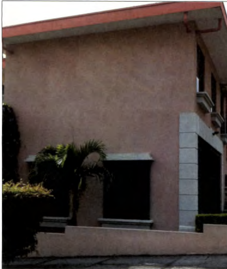
Figura 3-1. Fotografía de un muro de una vivienda
