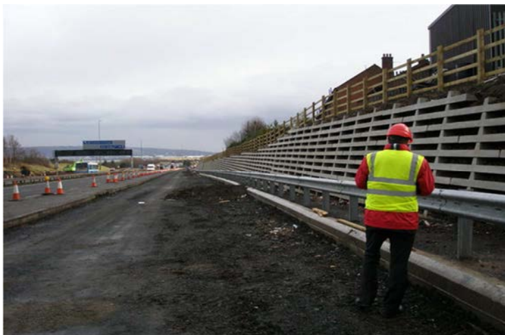
Figura 2.2 Foto de un muro de criba
