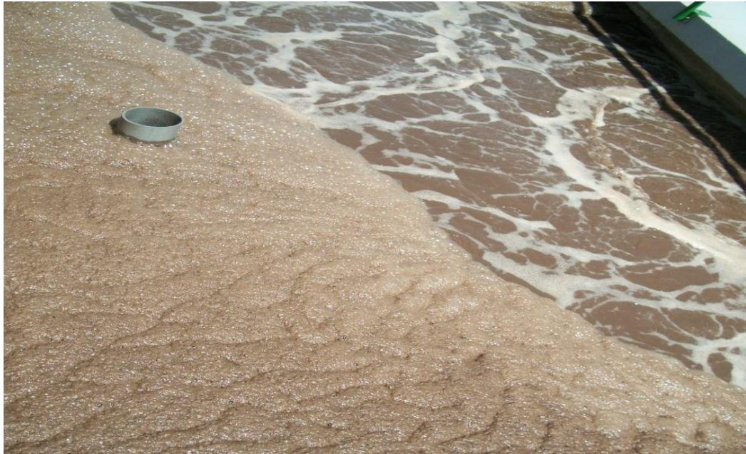
Figura 3.3.2 Espuma en el tanque de aireación
