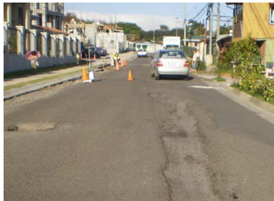
Figura 3.9: Desprendimiento de carpeta
