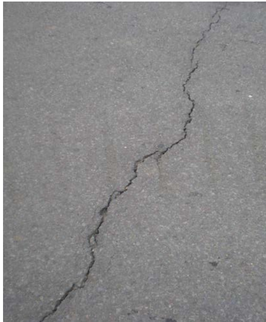
Figura 3.6: Grieta longitudinal
