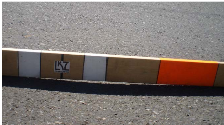
Figura 3.7: Hundimientos
