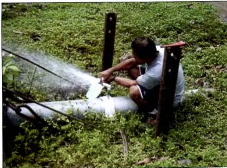
Figura 5.6. Fotografía de la tubería de conducción de 200 mm.
