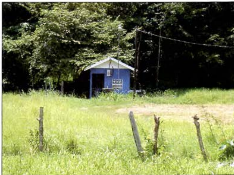
Figura 5.3. Fotografía de caseta del Pozo #1.
