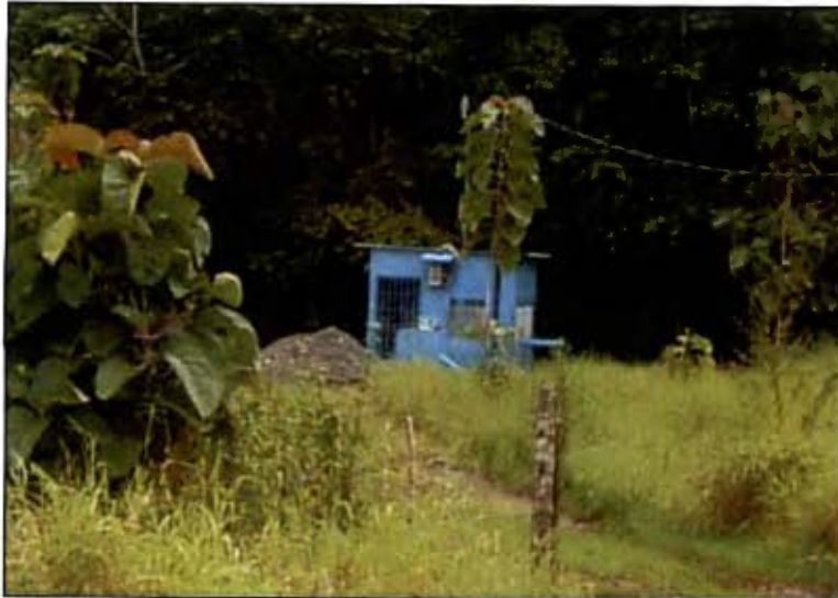
Figura 5.4. Fotografía de la caseta del Pozo #2.
