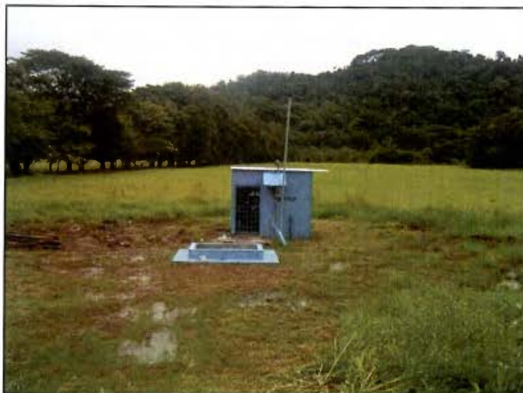
Figura 5.5. Fotografía de la caseta del Pozo #3.
