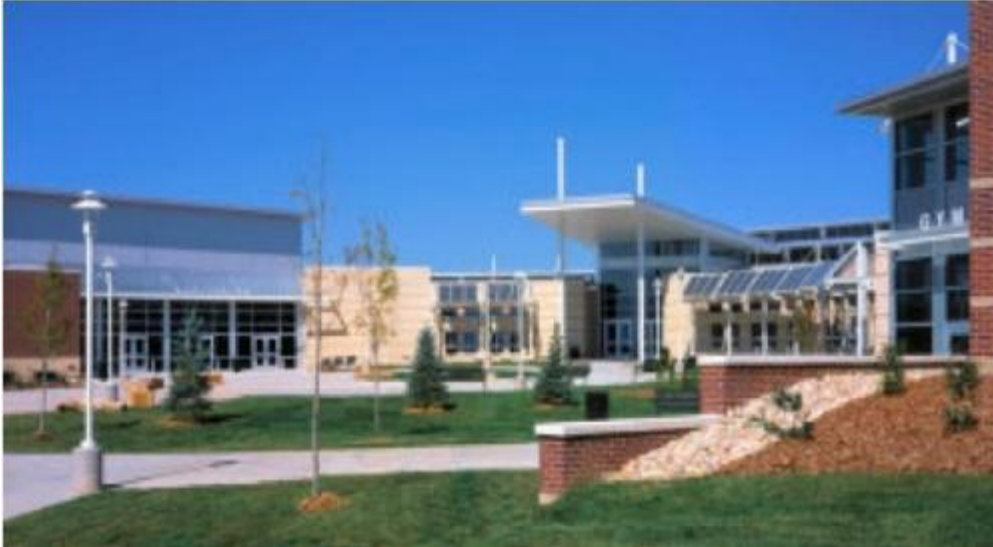
Figura 3.1 Ventanales de la escuela.
