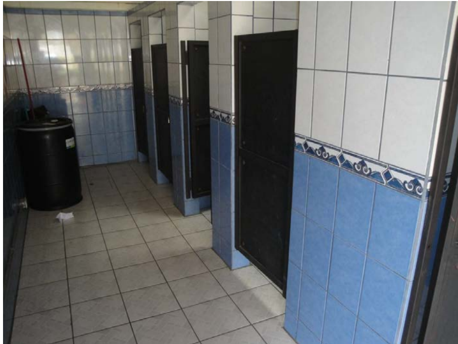
Figura 3.5. Puertas de servicios sanitarios.
