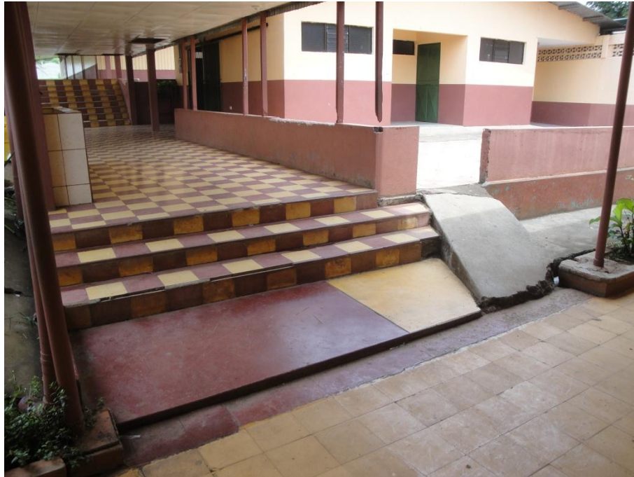
Figura 3.8. Ejemplo de rampas de acceso
