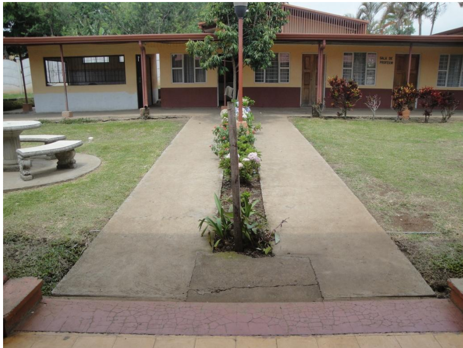
Figura 3.10. Pasillo exterior en concreto
