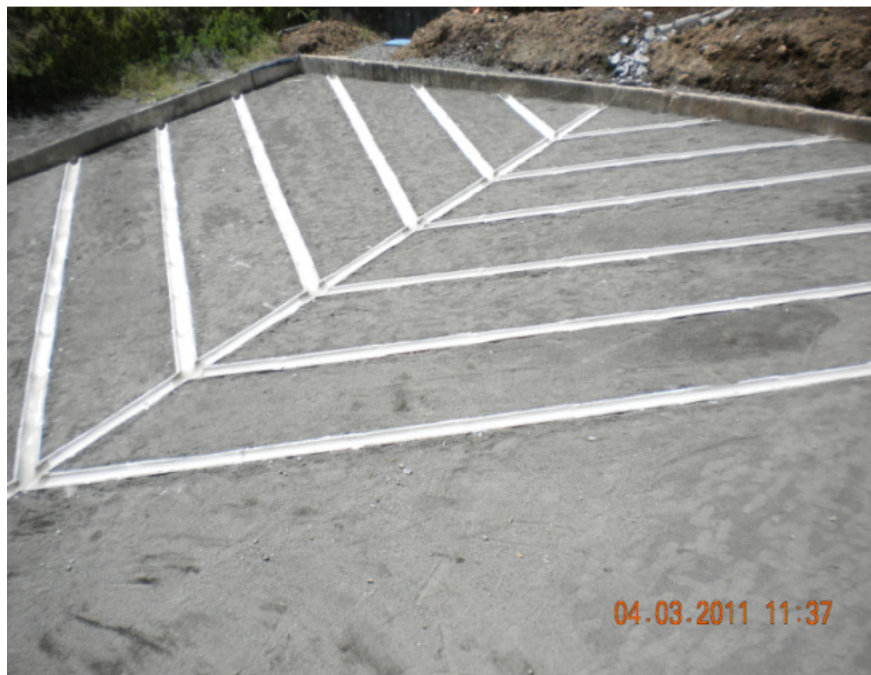
Figura 2.8. Fotografías de los lechos de secado del F.A.F.A. del la urbanización El Mora
