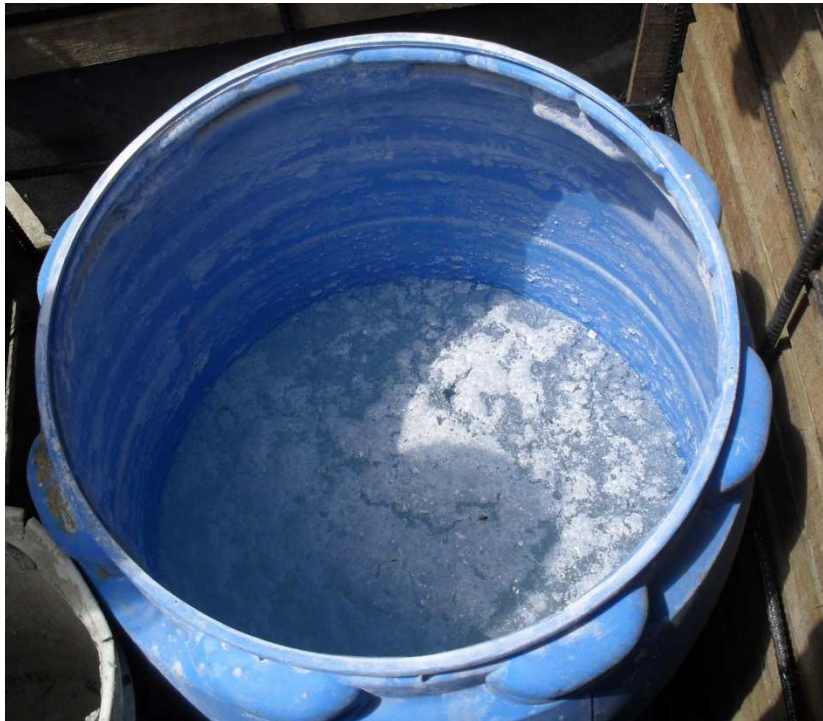
Figura 10. Mezcla de hipoclorito de calcio con agua
