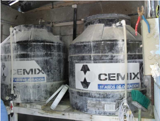
Figura 23. Equipo de cloración hipoclorito de calcio granulado
