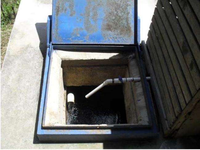
Figura 3. Estación con mezcla de hipoclorito de calcio granulado y agua.
