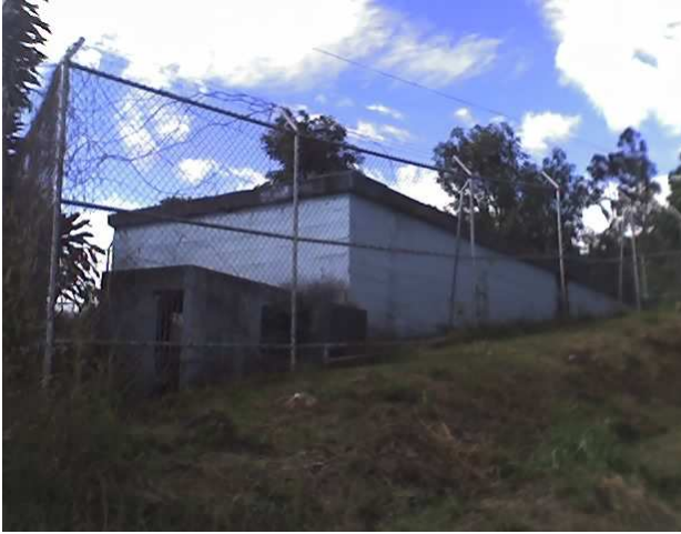
Figura 5. Tanque de almacenamiento
