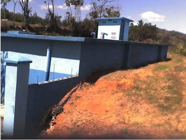
Figura 17. Caseta de cloración en tanque de almacenamiento
