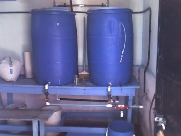
Figura 13. Equipo de producción de cloro a partir de hipoclorito de sodio
