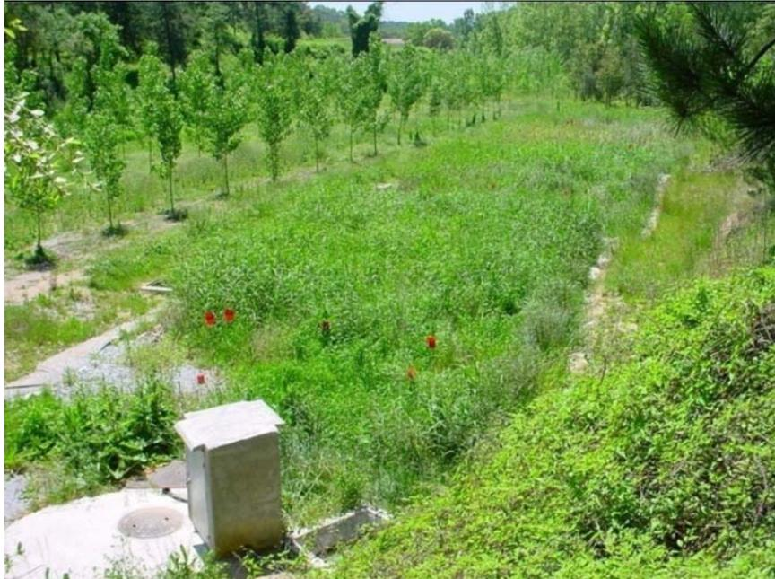
**Figura 3-26.** Fotografía de un humedal de flujo subsuperficial típico
