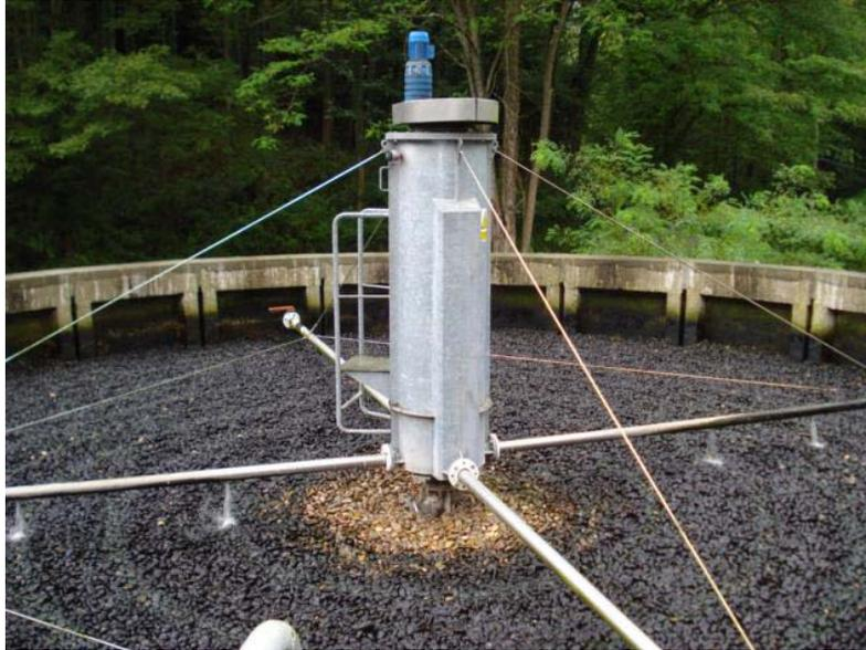
**Figura 3-24.** Fotografía de un biofiltro aeróbico
