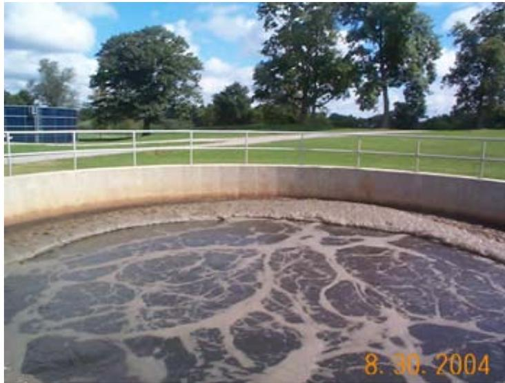
**Figura 3-30.** Fotografía de un digester aeróbico
