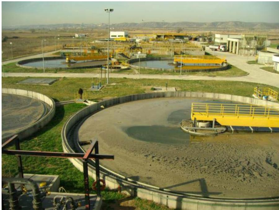
**Figura 3-29.** Fotografía de un adensador por gravedad
