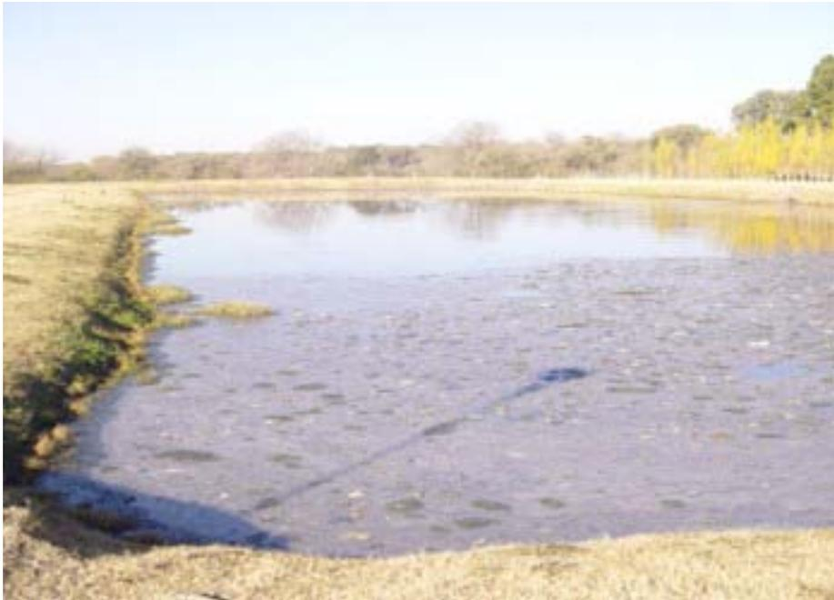
**Figura 3-14.** Fotografía de una laguna Anaeróbica
