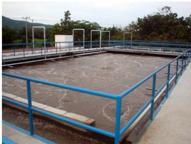
**Figura 3-20.** Fotografía de tanque de aireación en sistema de lodos activados
