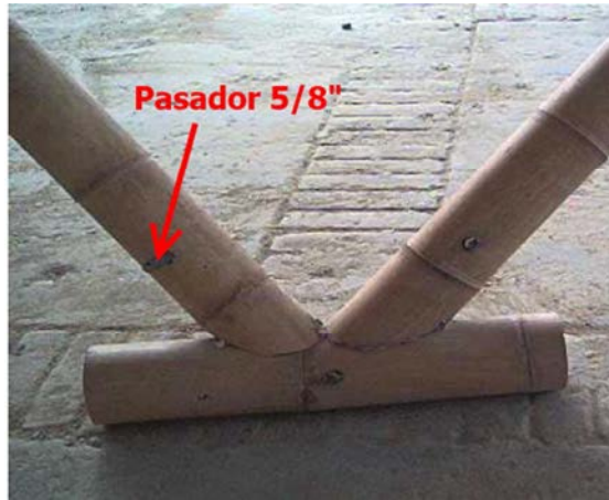
Figura A-84: Fotografía, unión Diego Jaramillo y Gisella Sanclemente
