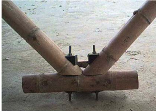
Figura A-80: Fotografía, unión Simón Vélez Modificada
