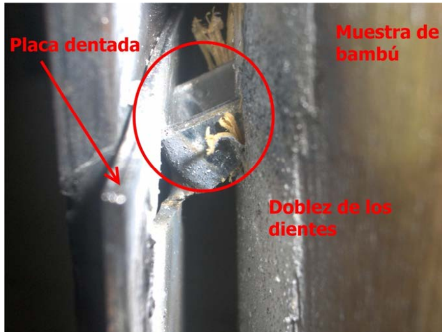
Figura 47: Falla de la unión debido al dobléz de los dientes en un ensayo a cortante
