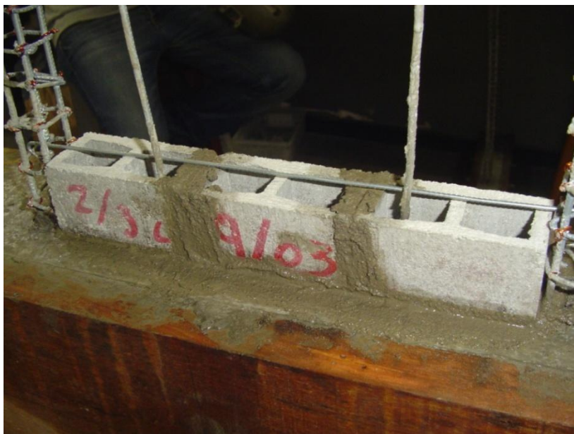
Figura 34. Colocación del mortero de pega y del acero horizontal
