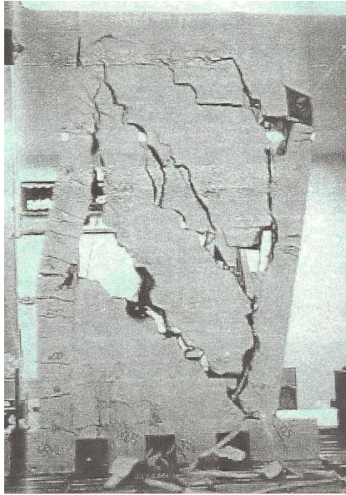
Figura 84. Muro confinado de Feoli G., 1996, después de la falla
