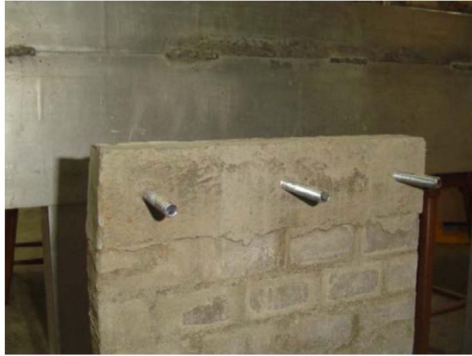
Figura 50. Desencofrado de la viga corona de una muro integral
