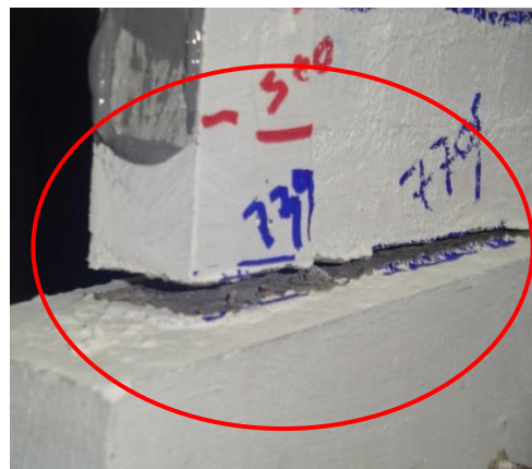
Figura 77. Levantamiento del muro en el lado de la tensión.
