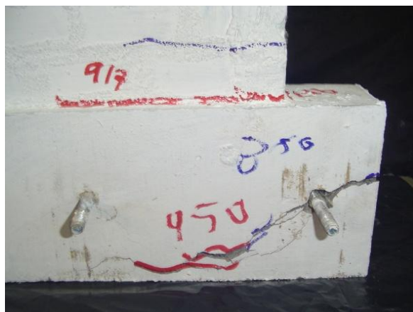
Figura 72. Ampliación de la foto anterior donde se observa la falla en la fundación.
