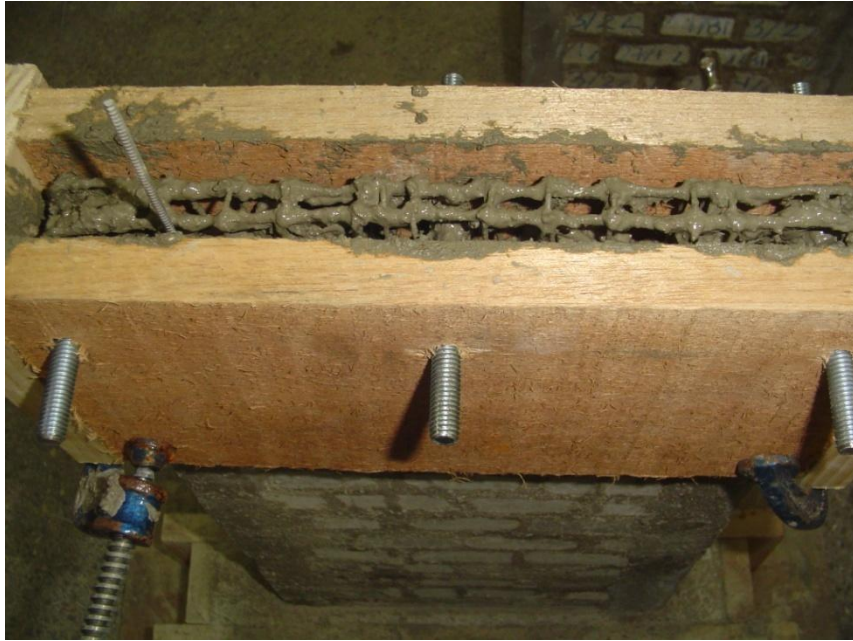
Figura 48. Proceso de colado de la viga corona
