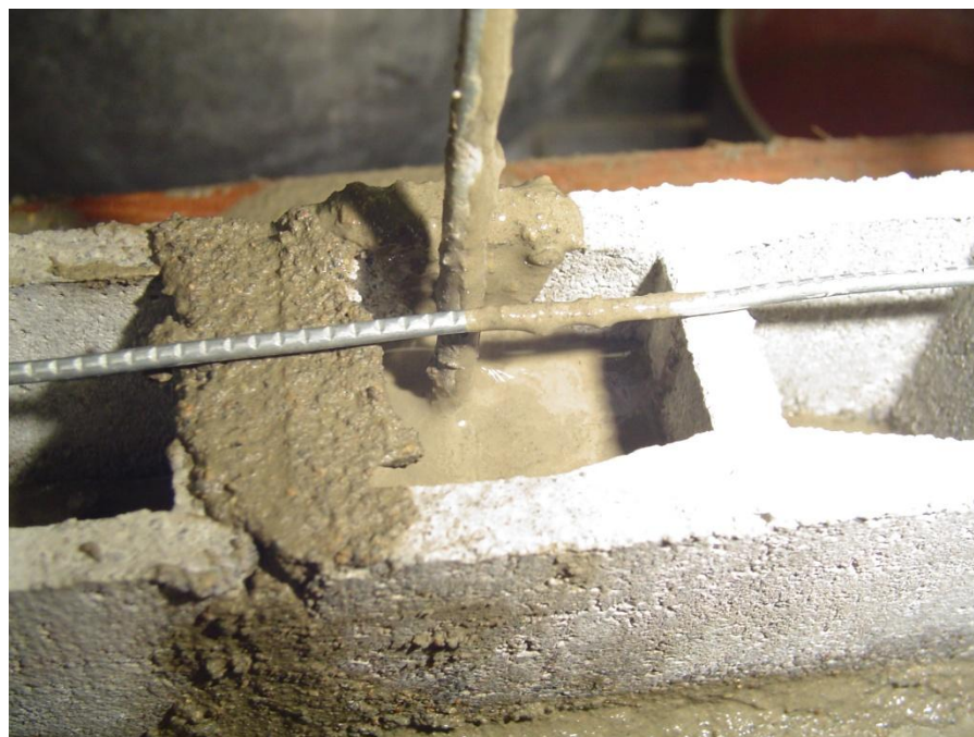
Figura 36. Colocación del microconcreto de relleno
