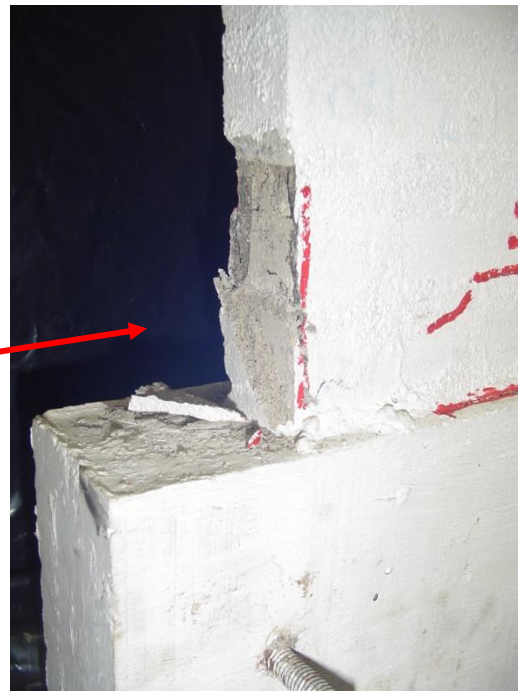
Figura 62. Compresión del muro integral #1
