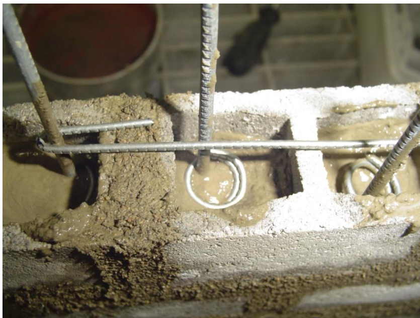
Figura 42. Anclaje del refuerzo horizontal y colocación de los aros de confinamiento en el muro integral
