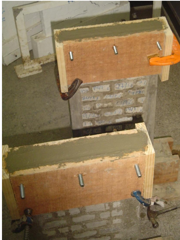
Figura 49. Colado de la viga corona en los muros confinados
