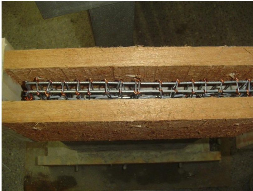
Figura 47. Encofrado de la viga corona de los muros integrales
