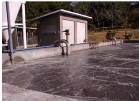
Figura 9: Reactor Biológico, Sedimentador y Sección inicial de la planta, respectivamente.
