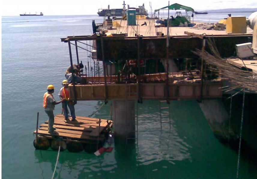
FIGURA 5.10 ENCOFRADO UTILIZADO EN REPARACIÓN DEL MUELLE DE CRUCEROS
