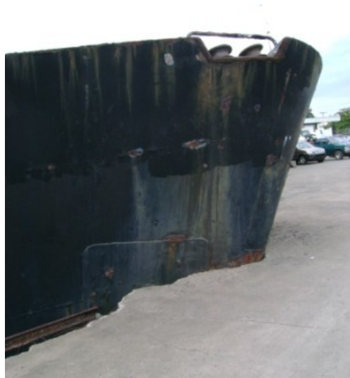
FIGURA 4.3 BARCO HUNDIDO DAÑANDO EL MUELLE 70
