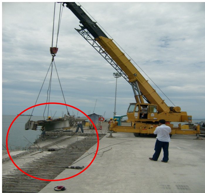
FIGURA 5.8 REMOCIÓN DE ELEMENTOS DAÑADOS DEL MUELLE DE CRUCEROS
