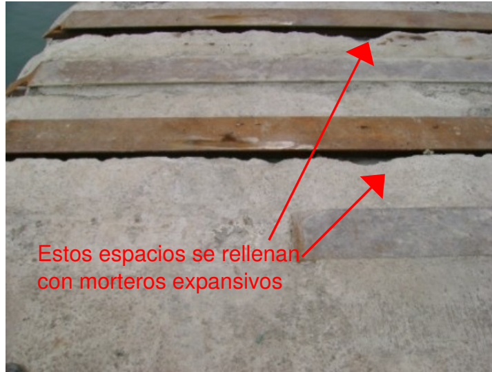
FIGURA 5.12 RIELES COLOCADOS EN RAMPA Ro/Ro, EN MUELLE DE CRUCEROS
