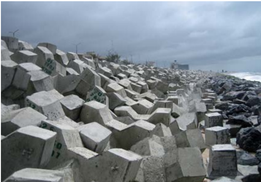
FIGURA 5.18 EJEMPLO DE APLICACIÓN DE XBLOC
