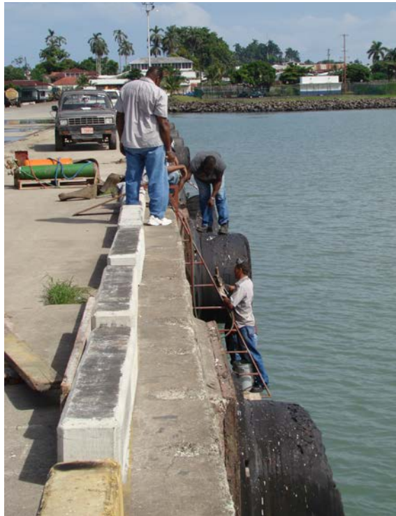
FIGURA 5.13 REMOCIÓN DE DEFENSA EN EL MUELLE 70
