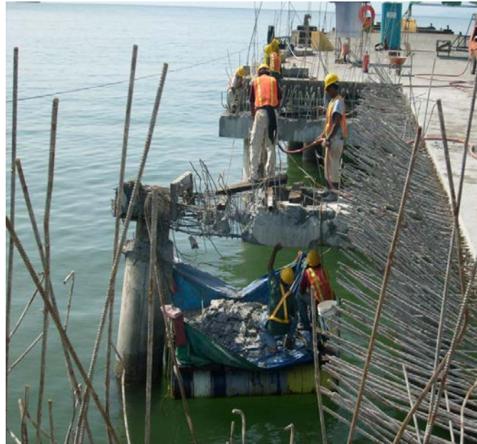
FIGURA 5.9 DEMOLICIÓN DE ELEMENTOS DAÑADOS DEL MUELLE DE CRUCEROS
