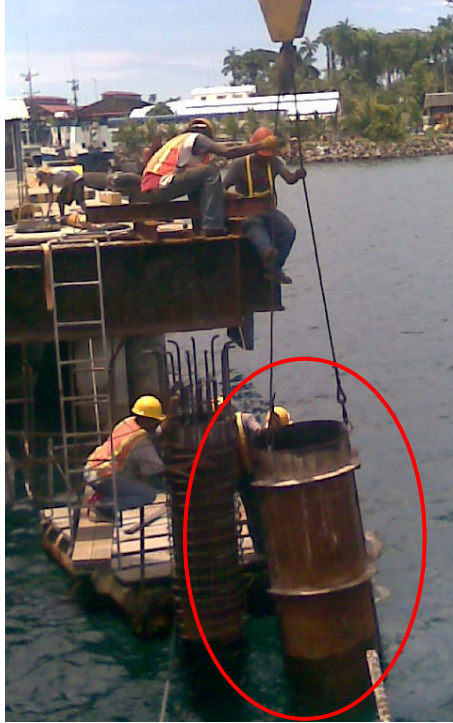
FIGURA 5.3 FORMAleta PARA EL RECUBRIMIENTO DEL PILOTE
