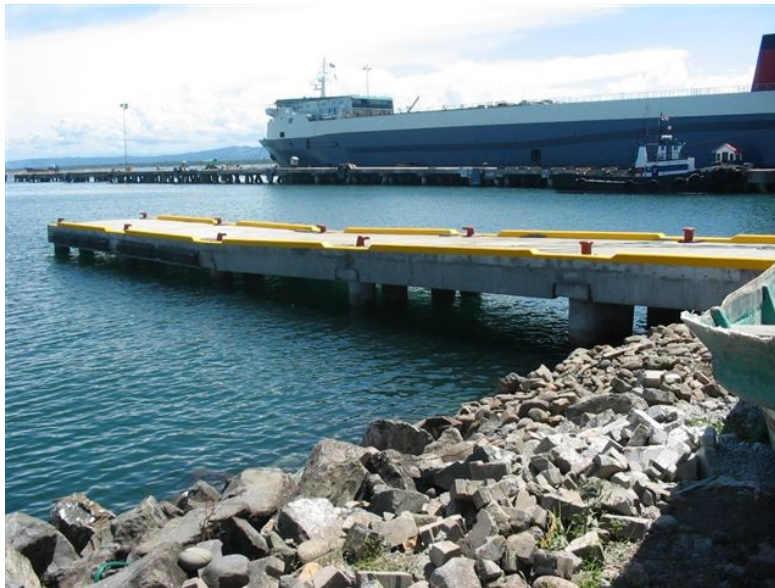
FIGURA 2.5 MUELLE DE REMOLCADORES
