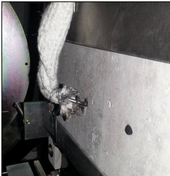
Imagen 42. Colocación y protección de un termopar tipo K para la medición de la temperatura del acero estructural presente en los entresijos estudiados
