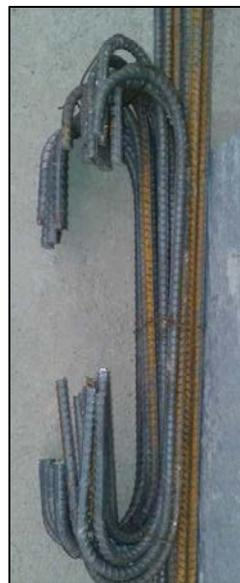
**Figura 32. Varillas verticales dobladas.**
