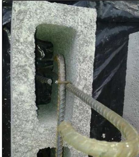
**Figura 36. Primer extremo de pared, varilla vertical #4.**
