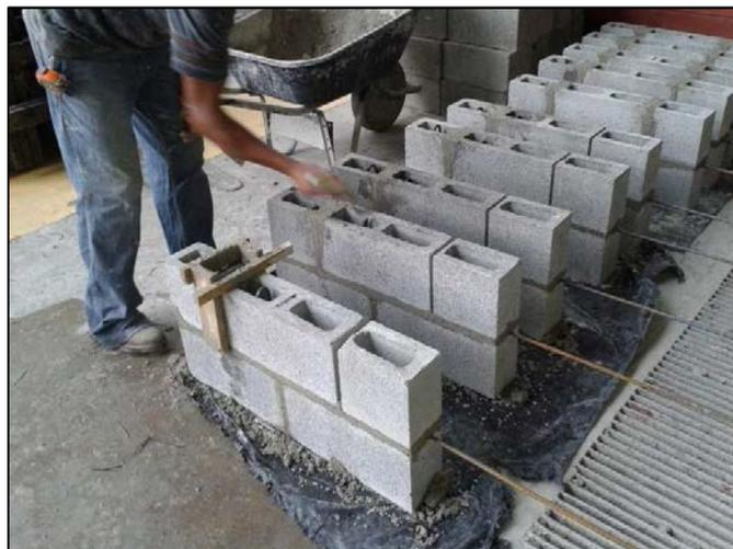
**Figura 42. Cinco especímenes del segundo extremo de pared casi listos.**
