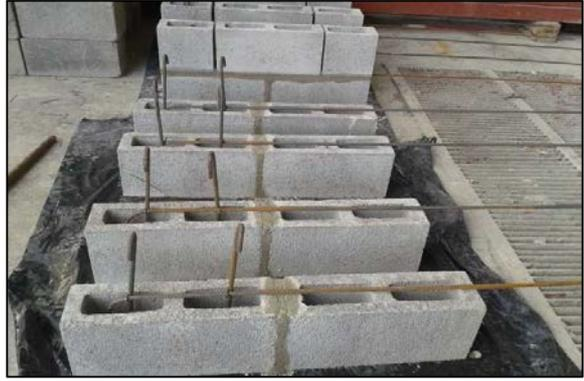
**Figura 40. Colocación de varillas y pega de bloques, segundo extremo de pared.**
