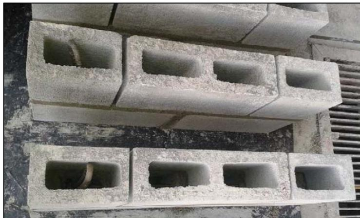
**Figura 37. Pega de bloques, primer extremo de pared.**
