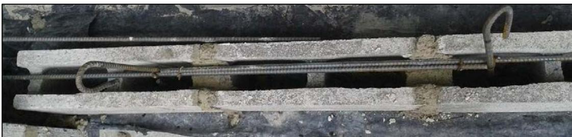
**Figura 51. Detalle de segundo tipo de traslapo, con viga bloque.**
