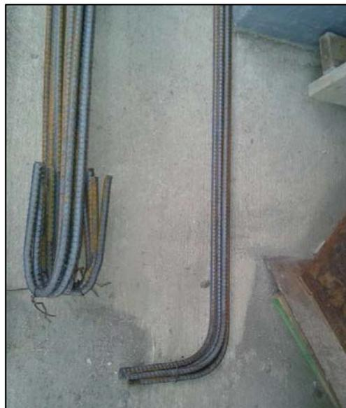
**Figura 35. Varillas horizontales #3 con gancho de 180° y 90°.**
