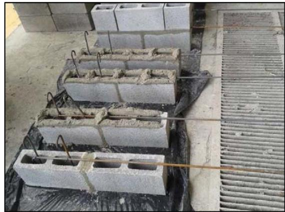
**Figura 41. Colocación de mortero de pega, segundo extremo de pared.**
