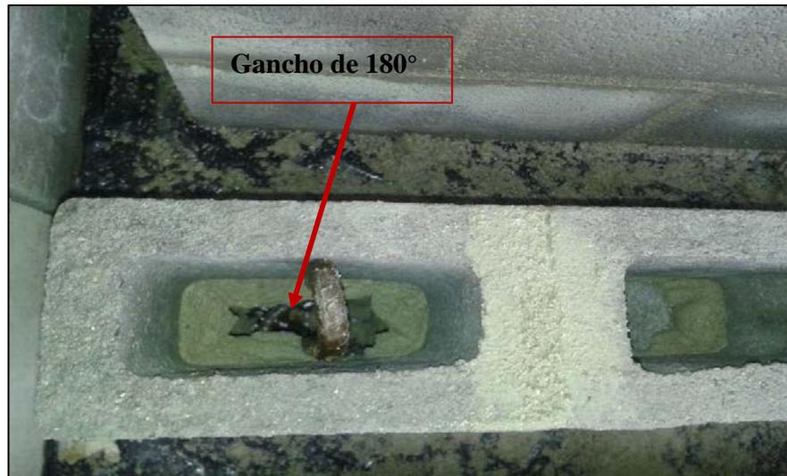
**Figura 43. Tercer extremo de pared, varilla vertical #4 y varilla horizontal #3 con gancho de 180°.**
