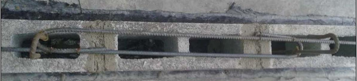
**Figura 48. Detalle de primer tipo de traslapo.**
