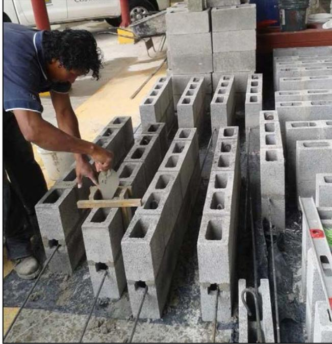
**Figura 52. Segundo tipo de traslapo en proceso de construcción.**
