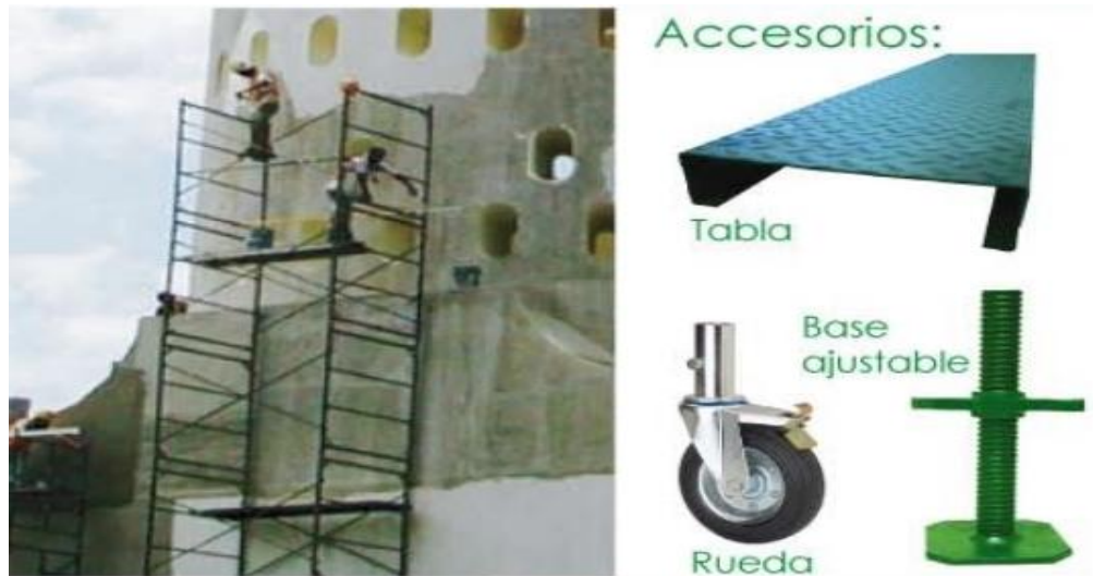
Figura 15. Sistema de andamiaje
