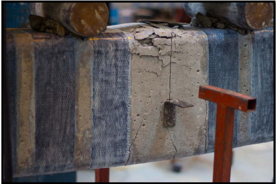
Figura F10. Grietas de flexión observadas en el elemento VO-3 después del ensayo de falla.
