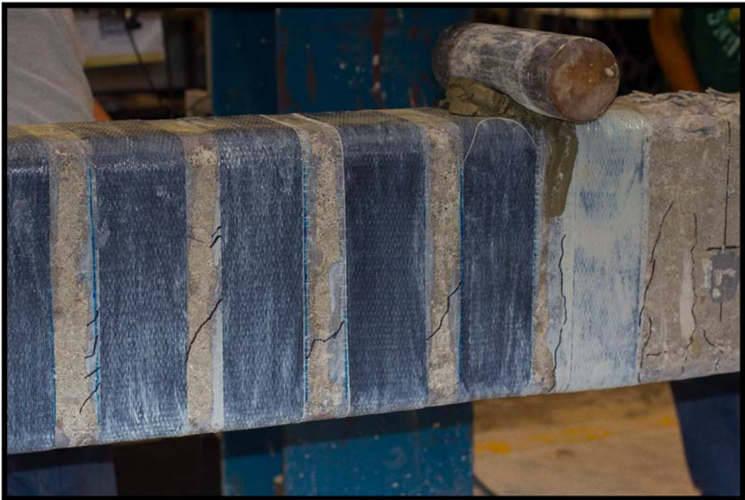
Figura F12. Grietas de cortante observadas en el espécimen VO-4 (resaltadas con marcador).
