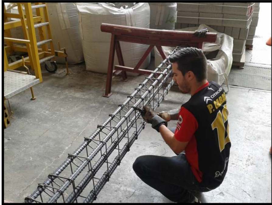
Figura 15. Proceso constructivo de armadura de acero de refuerzo.
