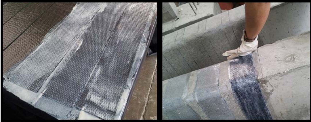
Figura 31. Proceso de colocación del sistema CFRP.
