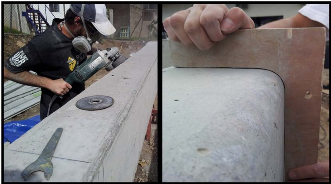
Figura 25. Acabado de vértices con esmeriladora y disco de desbaste de concreto.
