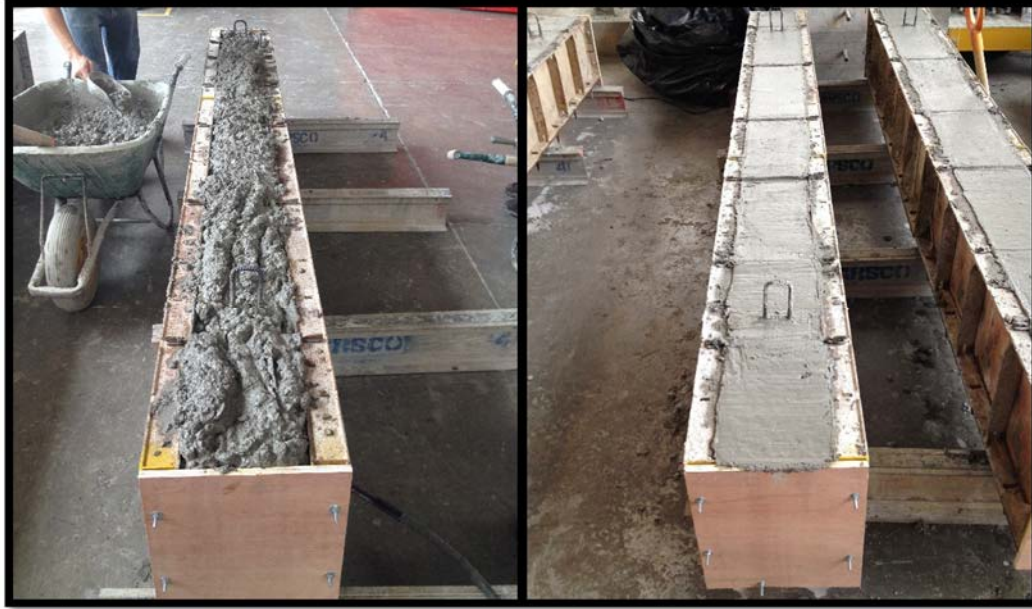
Figura 20. Colada de concreto realizada el 26 de mayo de 2014.
