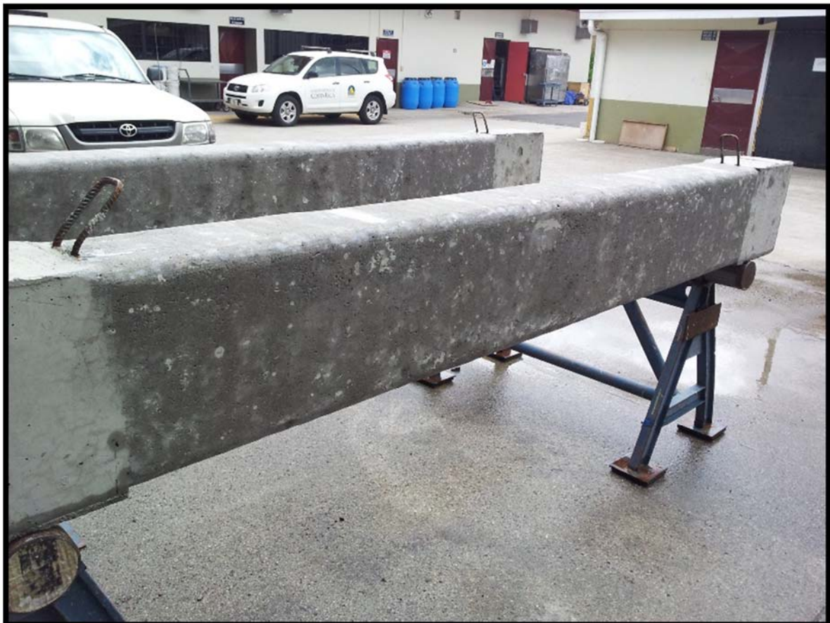
Figura 29. Acabado final de la superficie de los elementos a reforzar.
