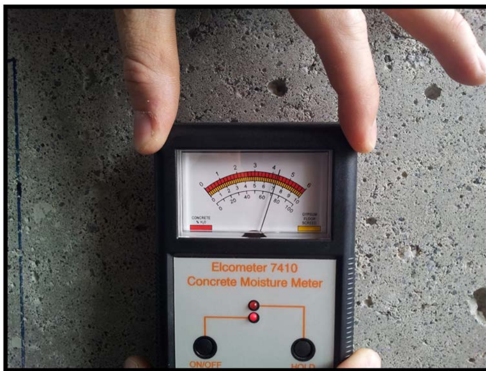
Figura 30. Medición de humedad superficial, al momento de la colocación de la fibra.
