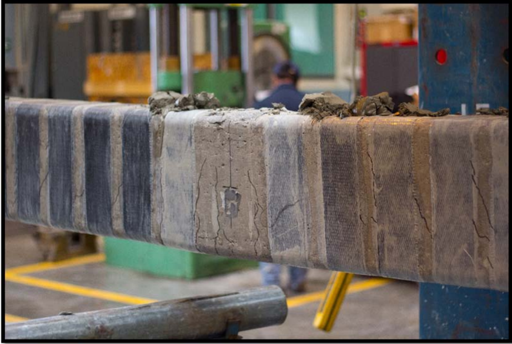
Figura F11. Estado del espécimen VO-4 después de finalizado el ensayo de falla.
