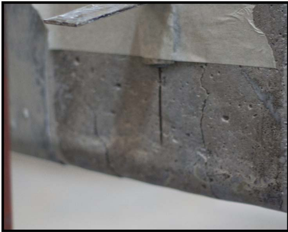
Figura F8. Grietas de flexión observadas en el elemento VO-2 después del ensayo de falla.
