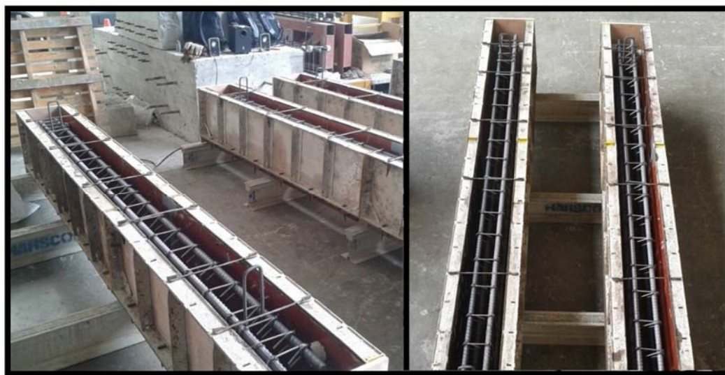
Figura 17. Disposición final de armadura de acero en encofrados.
