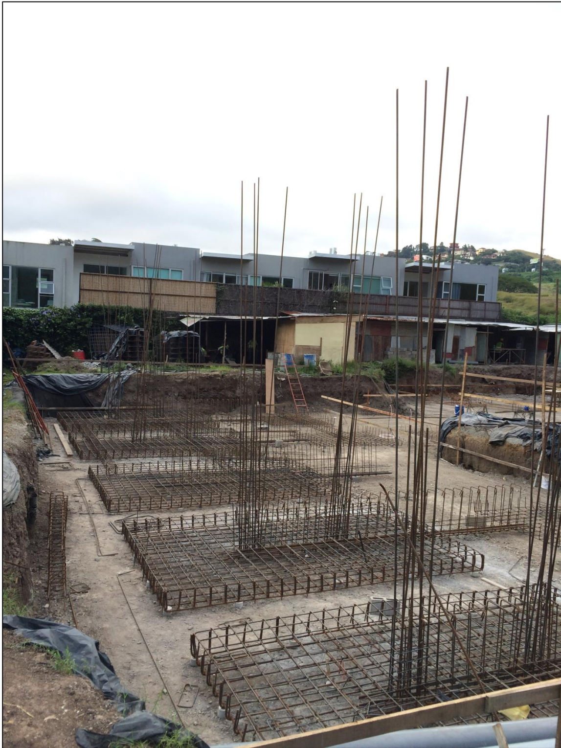
Figura 76. Placas de fundación del edificio La Rosaleda.
