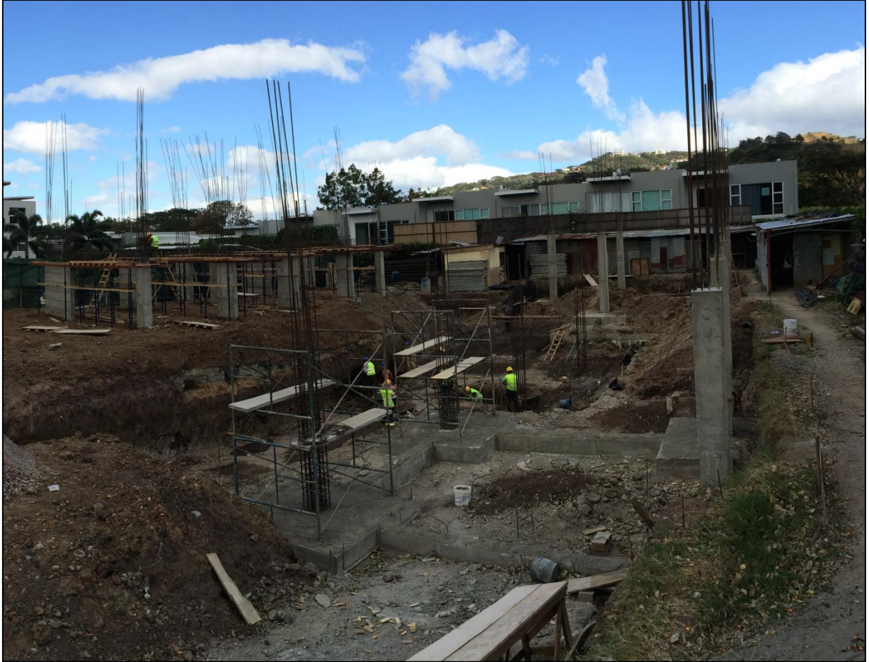
Figura 74. Avance real de obra a febrero, 2015
